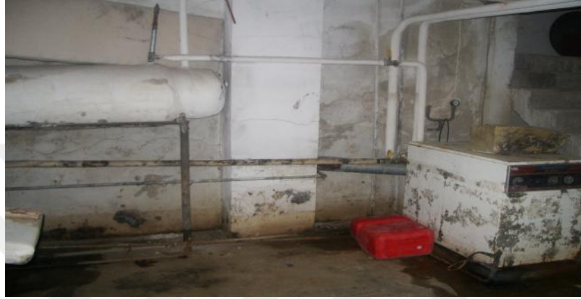
řekil 6.1: Yeraltı suyunun bina ierisinde oluřturduęu hasarlar (řimřek, 2005).
