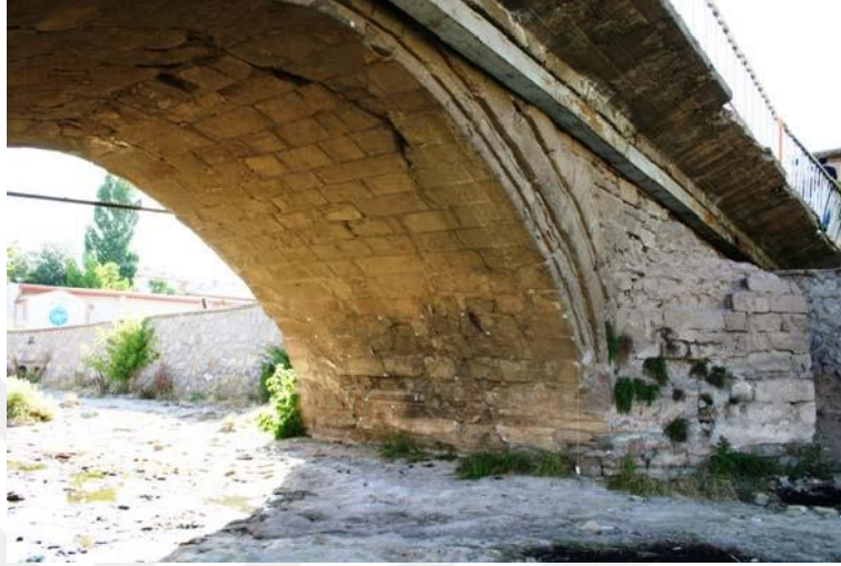
Şekil 4. 9. Restorasyon öncesi durumda köprüde meydana gelen bitkilenmeler (Ural, 2012).
