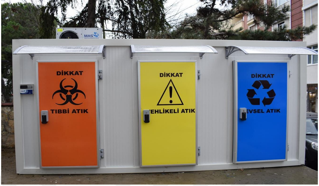
Şekil 2.12. Geçici atık deposu.
