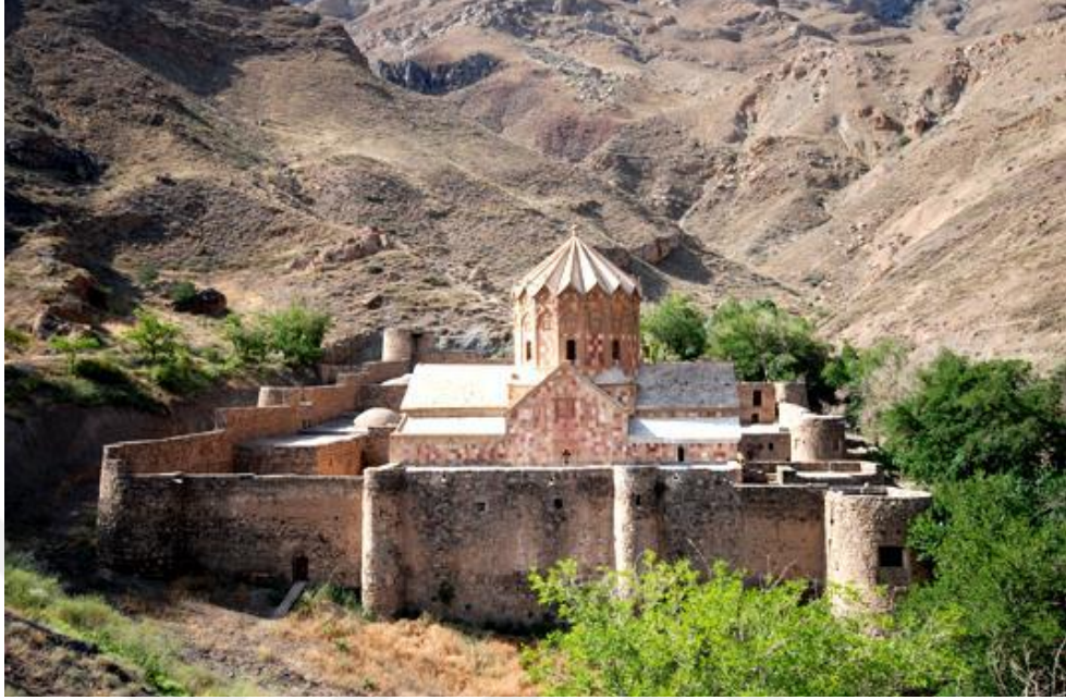
Resim 2. 125. St. Stephanos Manastır Kilisesi dış mekan görünüşü (URL-7)
