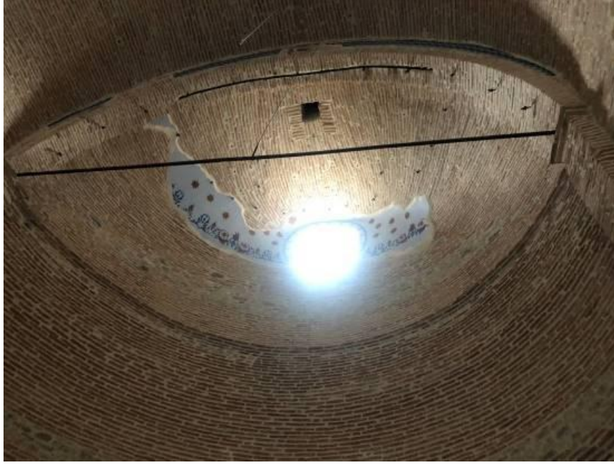
Resim 3. 39. Apsis kısmındaki tepe penceresi etrafında bulunan kalemişlerinin korunmuşluk durumu ve derzli tuğla-taş duvarı (kişisel arşiv, 2019)
