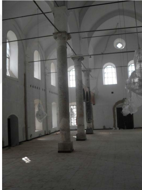
Resim 2. 28. Mekanı bölen duvar kaldırılmış hali (E.Fakıbaba)
