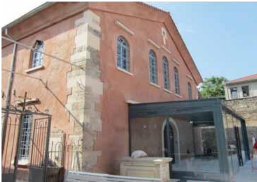
Resim 2. 33. Kilise batı cephesine eklenen camekanlı giriş (Y.Mimar Kevork Özkaragöz arşivi)
