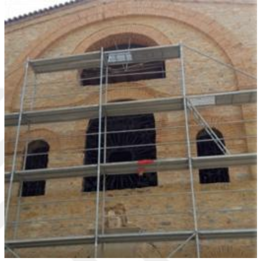
Resim 3. 34. Restorasyon uygulama aşaması (2018)
