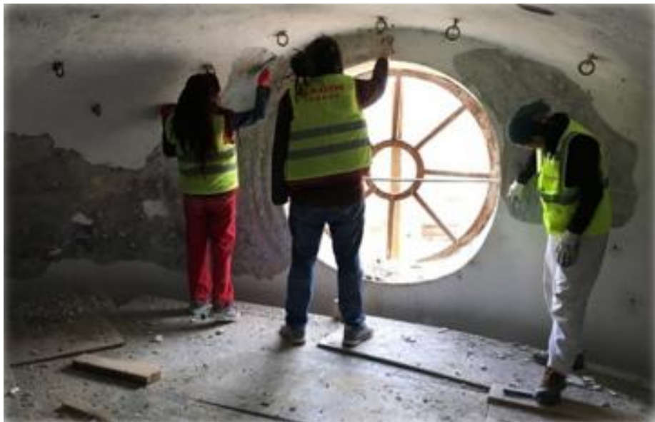
Resim 3. 38. Restorasyon uygulama aşamasında kalemişi raspa uygulaması (2018)
