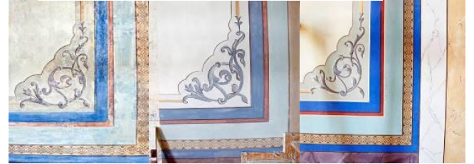
Şekil 3. 6. Restorasyon uygulama aşamasında kalemişlerine ait çalışmalar (2018)
