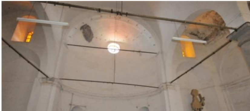
Resim 3. 32. Tonzlar arası demir gergilerin görünümü (2012)
