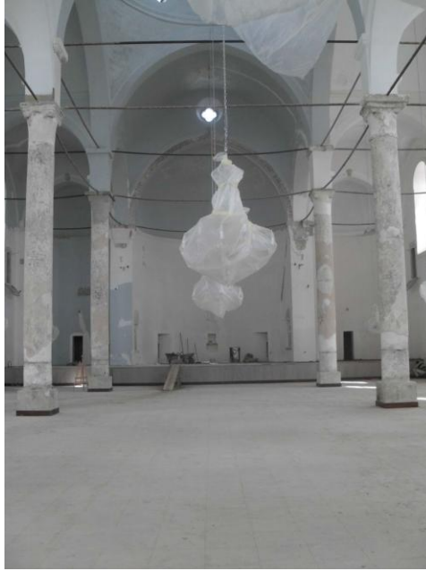
Resim 2. 27. Restorasyon aşamasında yapıda sütun başlıkları ve metal gergiler (E.Fakıbaba arşivi)
