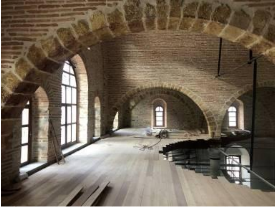
Resim 3. 37. Asma kat yenilenmiş ahşap karkas ve ahşap taban tahtası (kişisel arşiv, 2019)
