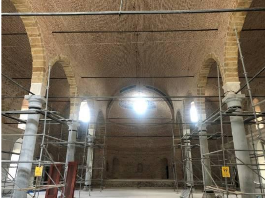
Resim 3. 33. Strüktürel açıdan korunan ve antipas sürülüp onarılan demir gergiler (kişisel arşiv, 2019)
