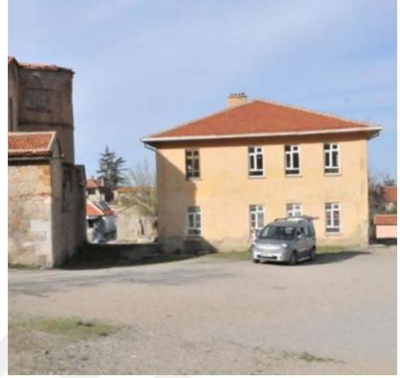
Resim 3. 40. Kilise arka cephesindeki yıkılan okulun görüntüsü (2012)
