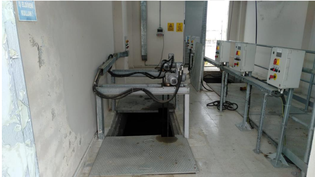
Şekil 3.7. Geri devir ve fazla çamur pompası.
