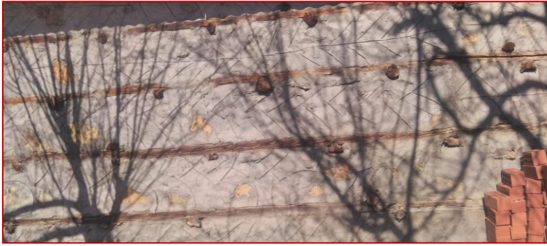
Resim 3.7. Düğmeli Duvar Görünüşü
