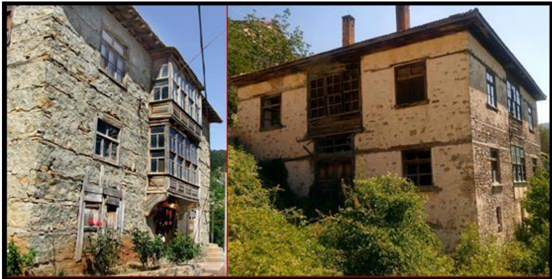
Resim 2.12. Orta Çıkmalı ve Çıkmasız Düğmeli Ev Örneği
