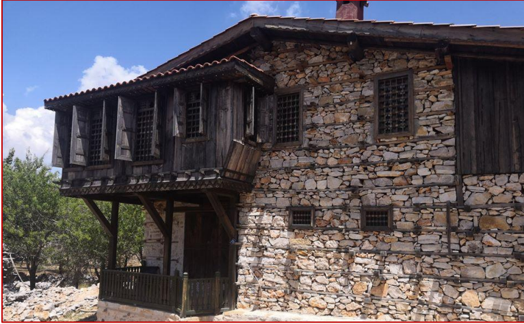
Resim 2.6. Sıvasız Düğmeli Ev Cephesi Örneği
