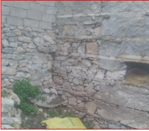
Resim 3.2. Yapının Orijinal Dış Sıvasız Kısım
