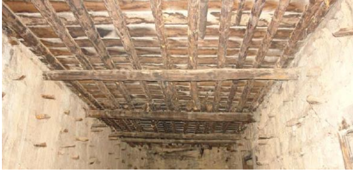
Resim 2.11. Çift Yönlü Döşemeye Örnek Fotoğraf [50]
