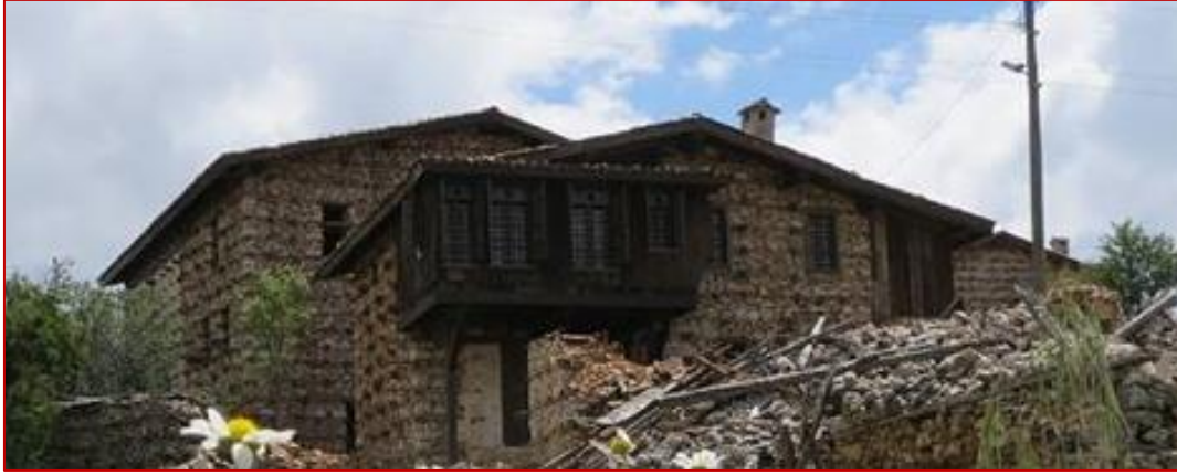
Resim 2.13. Köşe Çıkma Örneği
