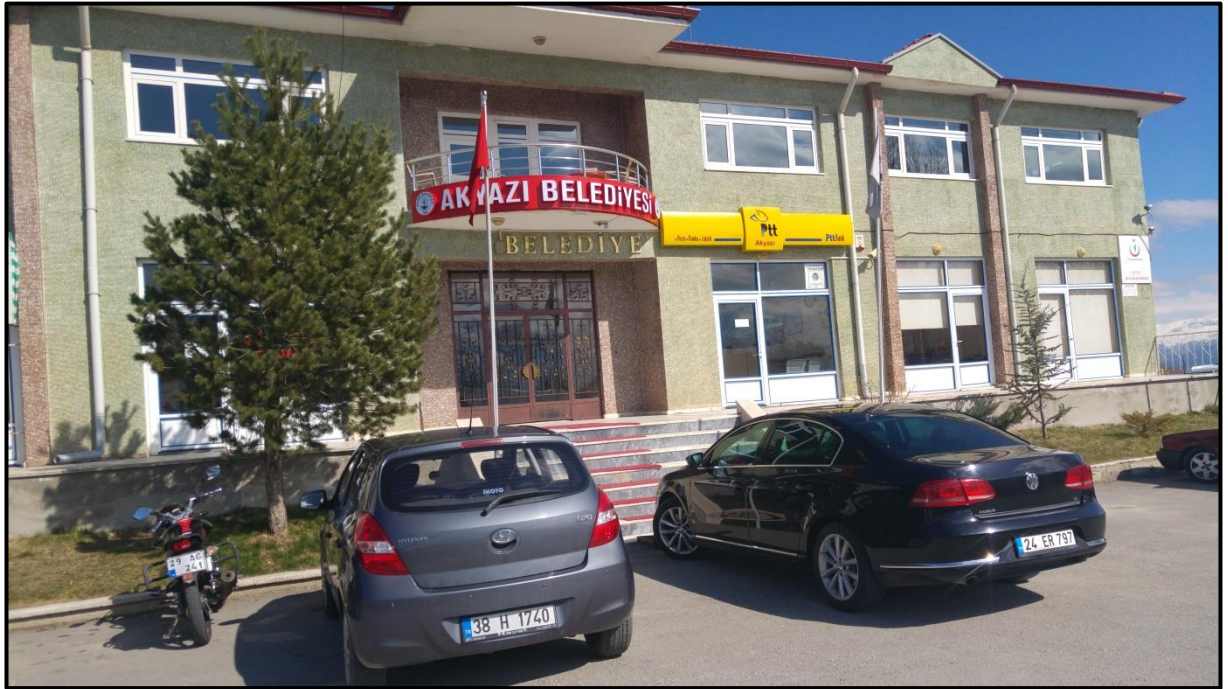
Fotoğraf 1.11. Akyazı Kasabasının Belediye Binasından Görünüm.
