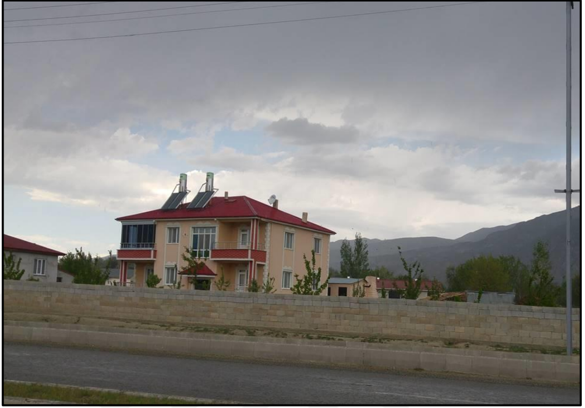
Fotoğraf 1.10. Fatih Mahallesi’ndeki İki Katlı Betonarme Konutlardan Görünüm.
