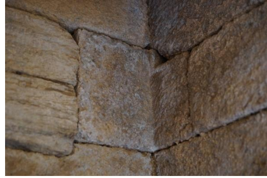
c: Ön oda kuzeydoğu köşe kilitleme tekniği.
