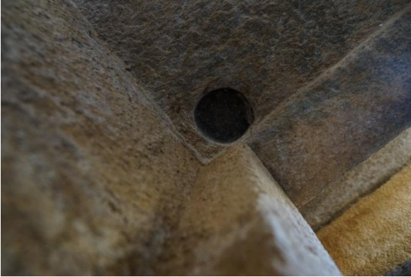
b: Asıl mezar oda kapısı üst mil yuvası.
