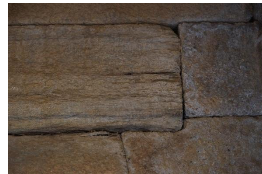
e: Ön oda kuzey duvar üzeri kitleme tekniği.
