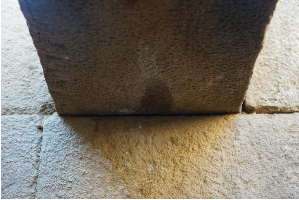
a: Oda Mezar bloklarındaki sivri uçlu alet izleri.
