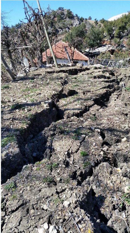
řekil 4.22. Meydana gelen heyelana ait tahribat grntleri (4 nolu heyelan noktası)
