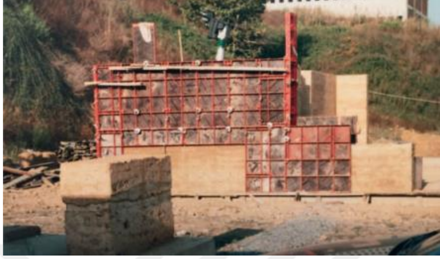
Şekil 2.15. Endüstriyel kalıplara döküm yapılması (Işık ve diğ, 1995)
