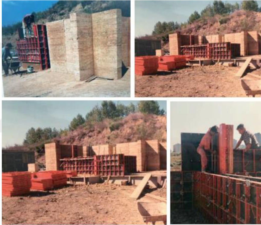
Şekil 2.4. Duvar kalıbı içinde alker toprak sıkıştırması aşamaları (URL-1)
