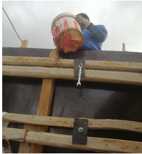
c) Karışımının kalıba dökülmesi
