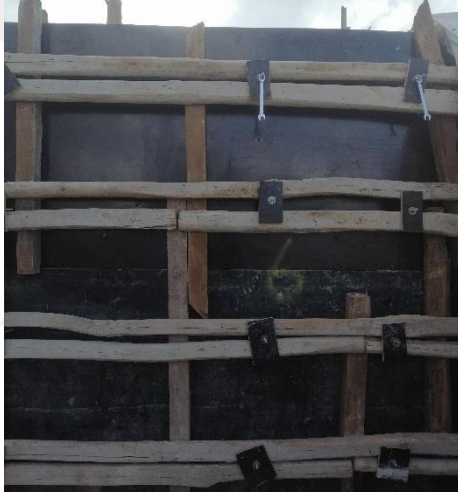
a) Kalıp kurulması
