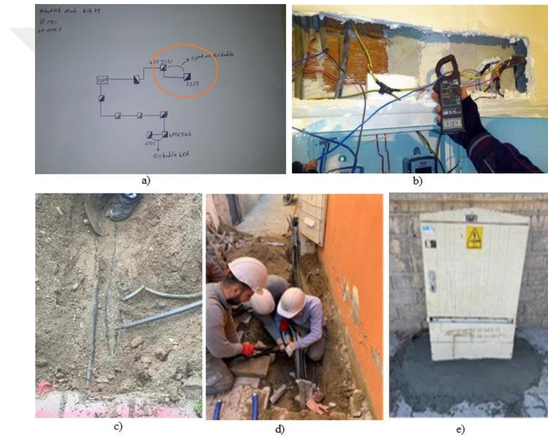
Şekil 1.2. Alçak gerilim güç kablolarında kayıt dışı tüketim tespiti ve mücadele örnekleri (Güleydin vd., 2022)
