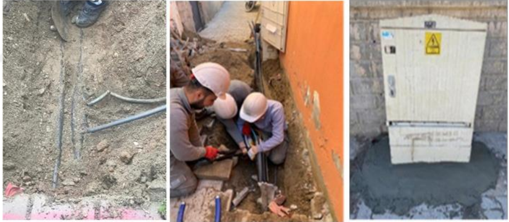
Şekil 1.5. Kayıp enerji tespiti sonrası onarım örnekleri (Güleydin vd., 2022)
