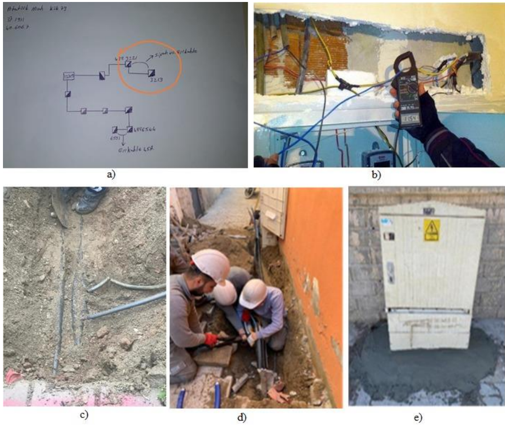
Şekil 1.2. Alçak gerilim güç kablolarında kayıt dışı tüketim tespiti ve mücadele örnekleri (Güleydin vd., 2022)
