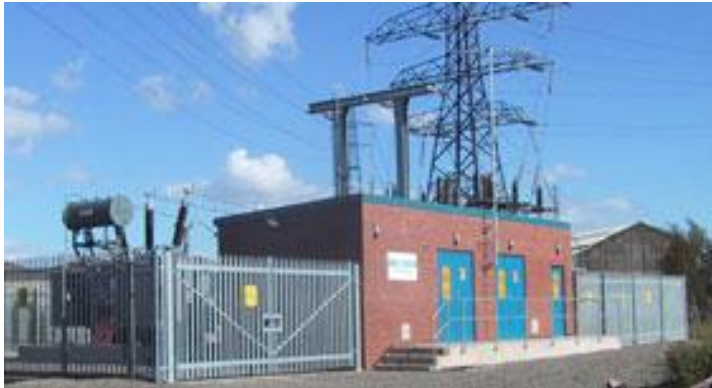
Şekil 2.1. Güç trafosu ve dağıtım merkezi içeren birincil dağıtım yapısı [18]
