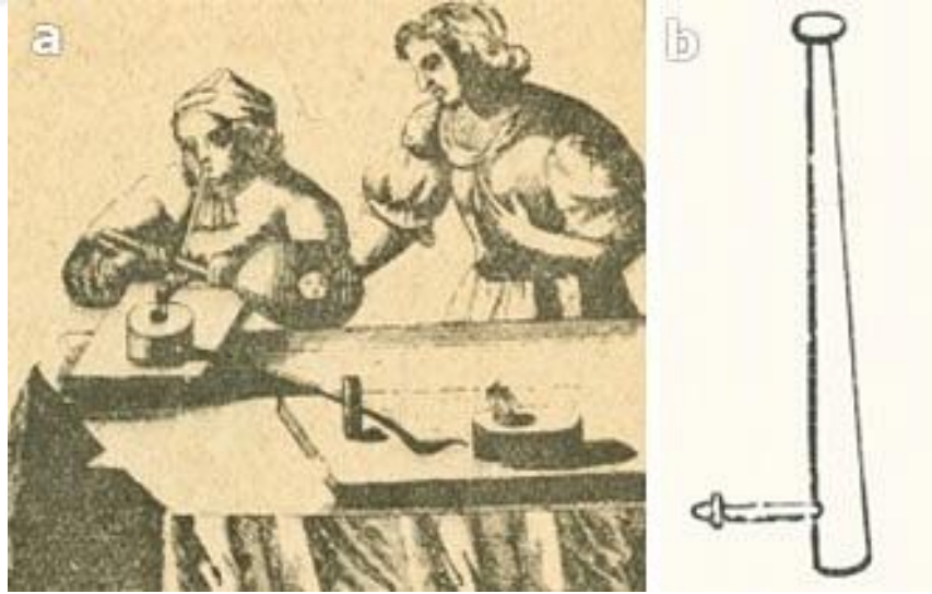
Görsel 3.1. Üfleme borusu ile lambada çalışan bir kadın ve üfleme borusu ( https://www.cmog.org/article/lamp )
