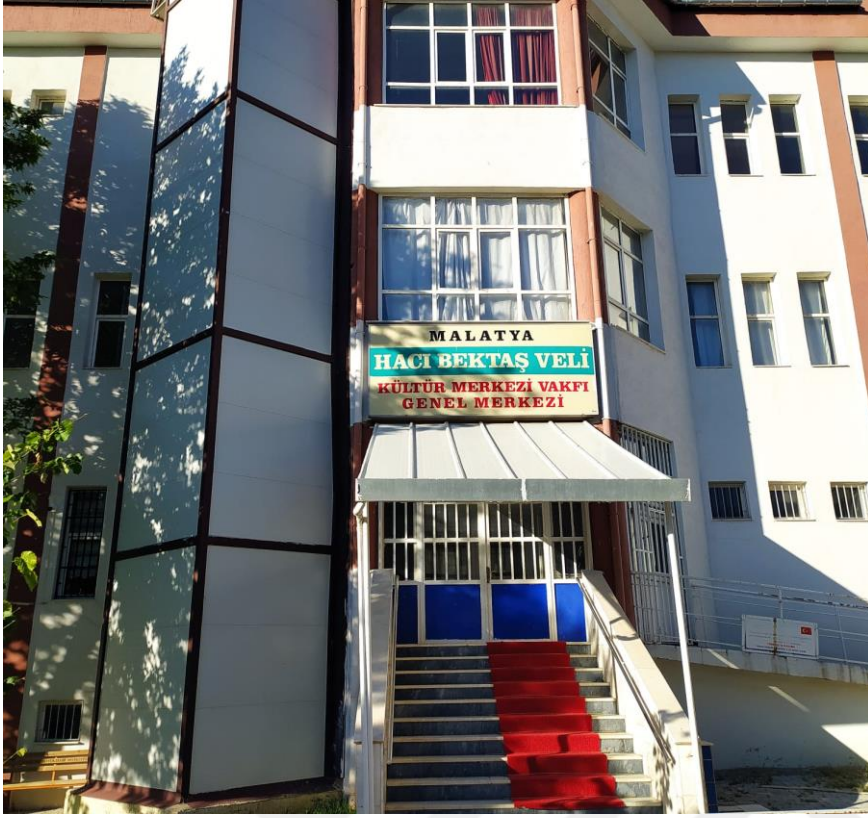
Fotoğraf 11: Hacı Bektaş Veli Kültür Merkezi Vakfı binası
