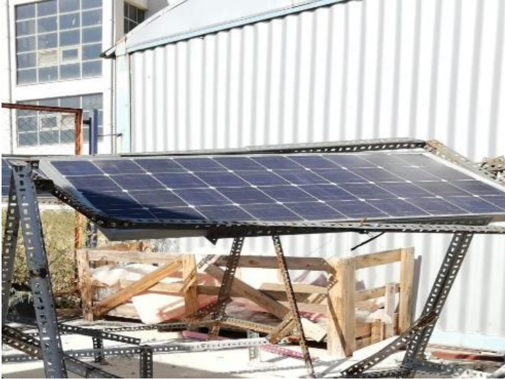
Resim 3.8 Panelin elik ereveye montajı.
