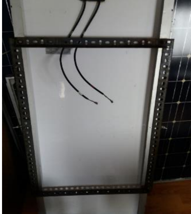
Resim 3.5 Panelin çelik iç çerçeveye montajı.
