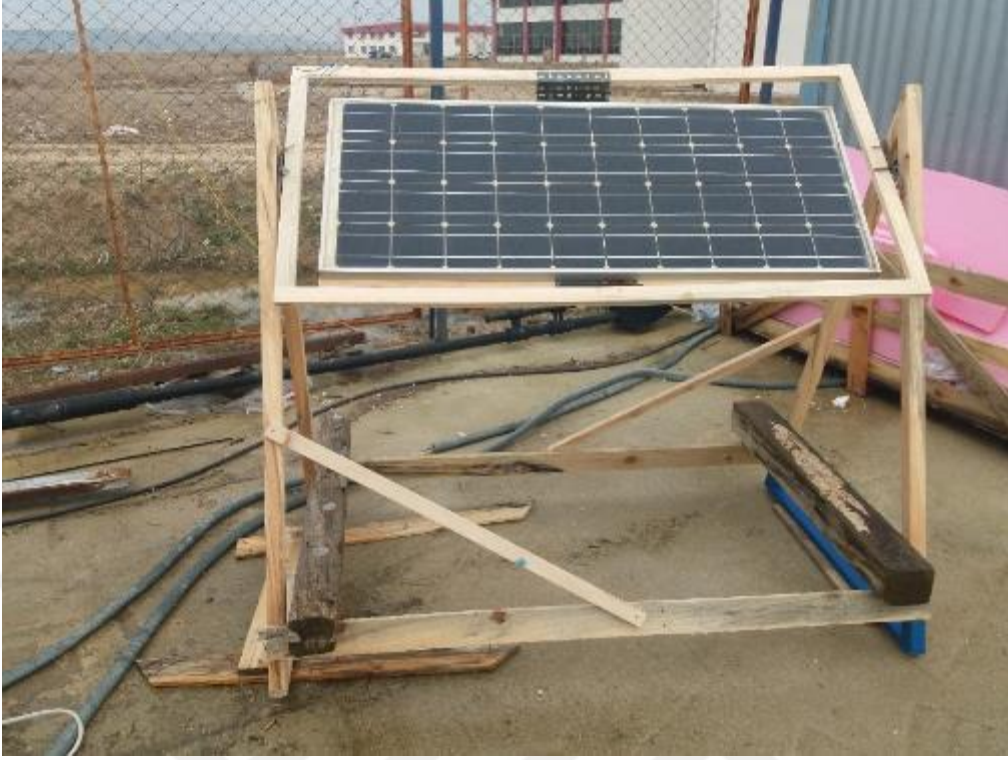
Resim 3.7 Panelin ahşap çerçeveye montajı.
