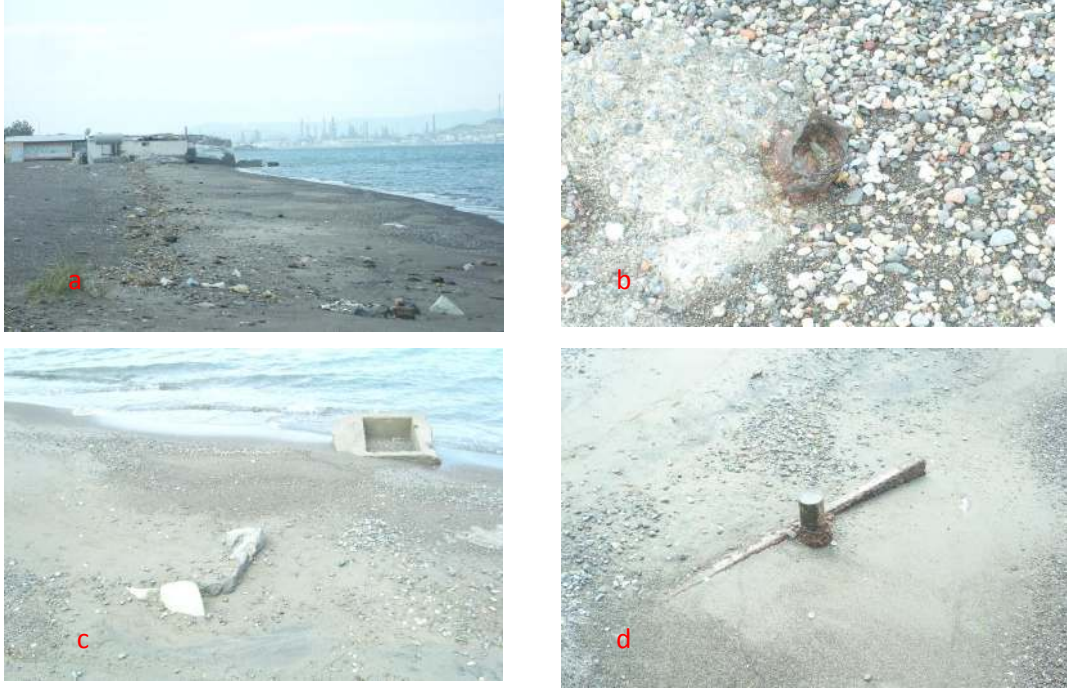
Şekil 3.13 Arazi ziyaretlerinde çekilen, kıyı çizgisinin kıyıda bulunan yapıların yıkılmasına sebep verecek kadar geri çekilmesini gözlediğimiz kıyı fotoğrafları.
