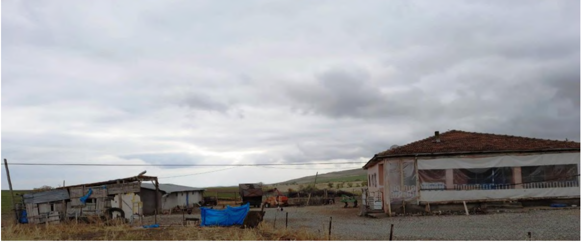
Fotoğraf 21. Evin Yanına Yapılan Ahır ve Depo Eklentileri( Yukarı Sülmenli Köyü Civarı)
