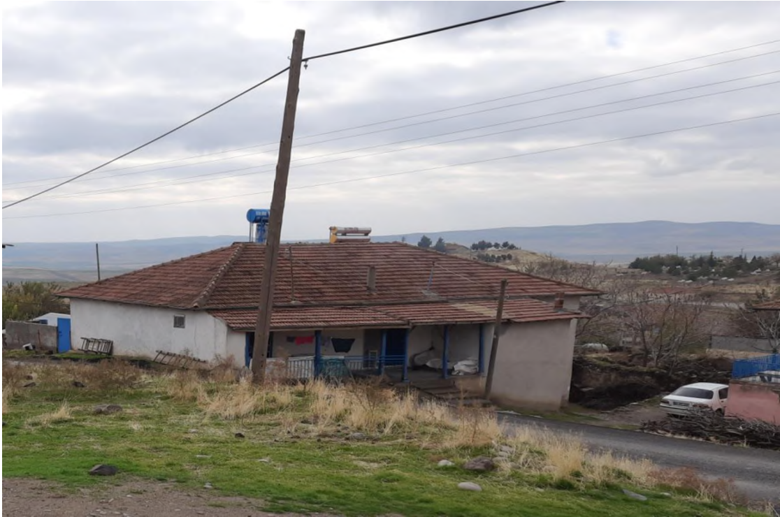
Fotoğraf 16. Kıрма Çatı Örneği (İsaköy)
