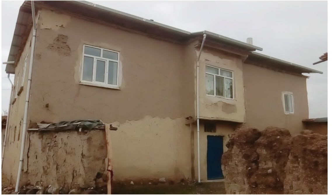
Fotoğraf 14. İki katlı kerpiç mesken örneği(Aşağı Sülmenli köyünde bulunan bu mesken, havzaya özellikle 2000 yıllardan önce hâkim mesken tipini oluşturmaktadır.)
