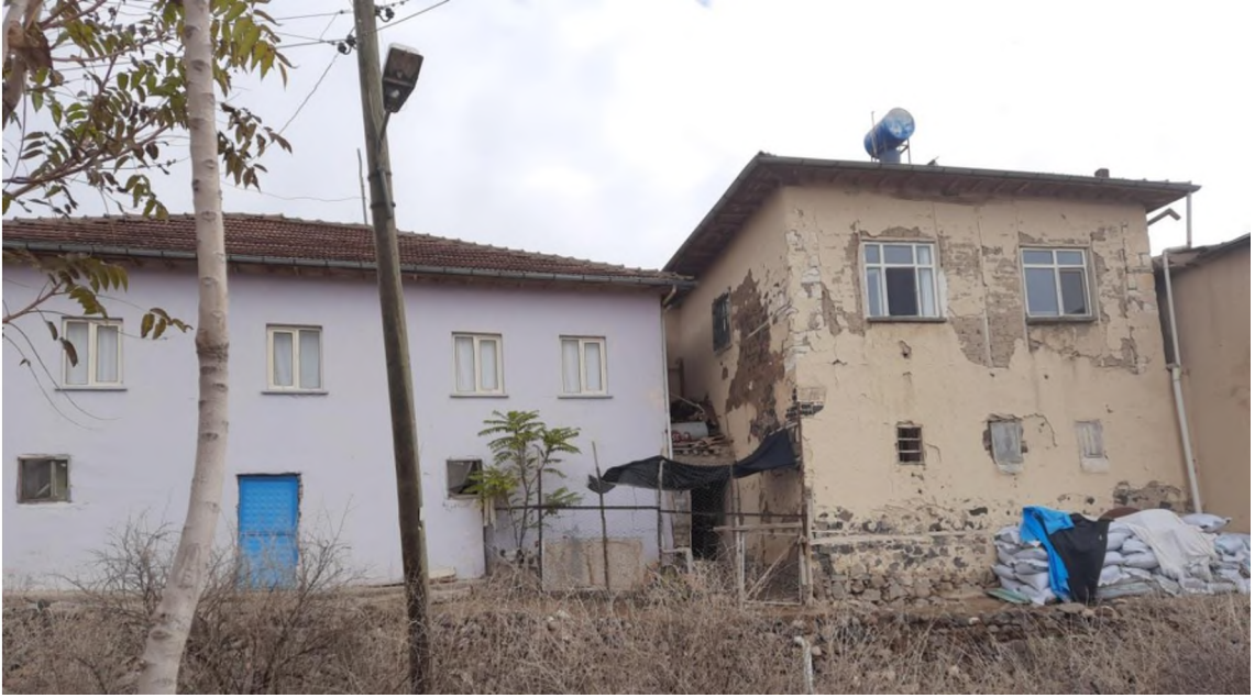
Fotoğraf 12. Betonarme ve Kerpiç Yapıdan Oluşan Mesken Örnekleri (İsaköy)
