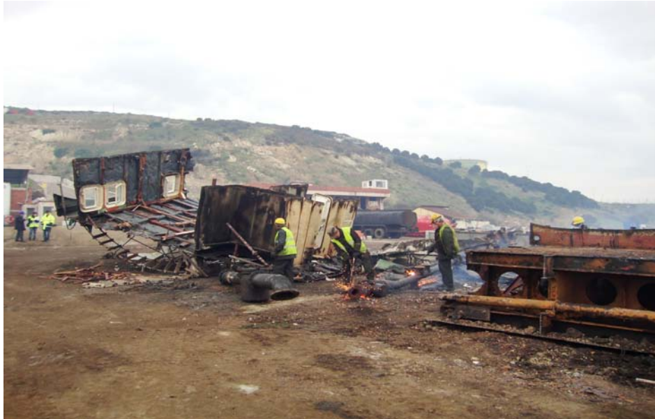
Resim 4. Kaynaklı Kesim Yapma Çalışmaları, Aliğa 2010.
