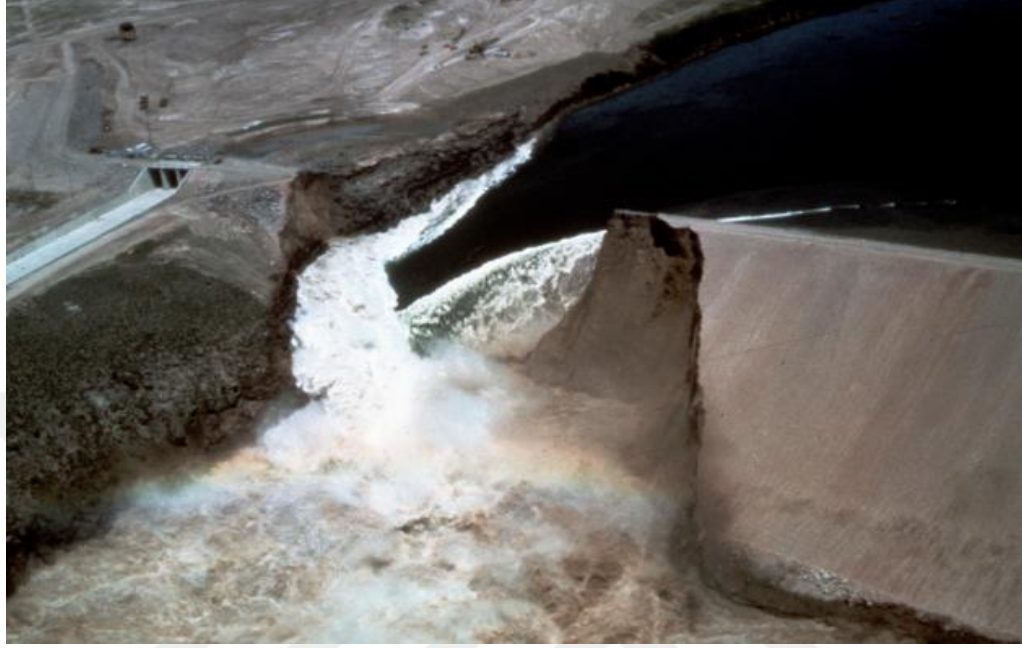
Şekil 14. Borulanma nedeniyle yıkılan Teton Barajı
