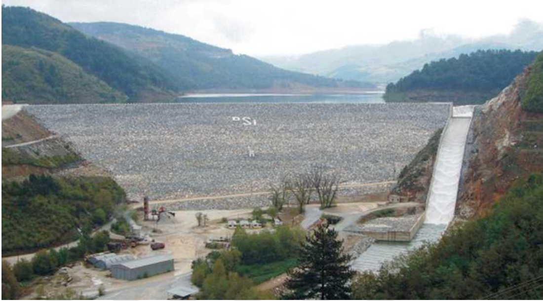
Şekil 5. Toprak dolgu baraj örneği Yapraklı Barajı (URL-6).
