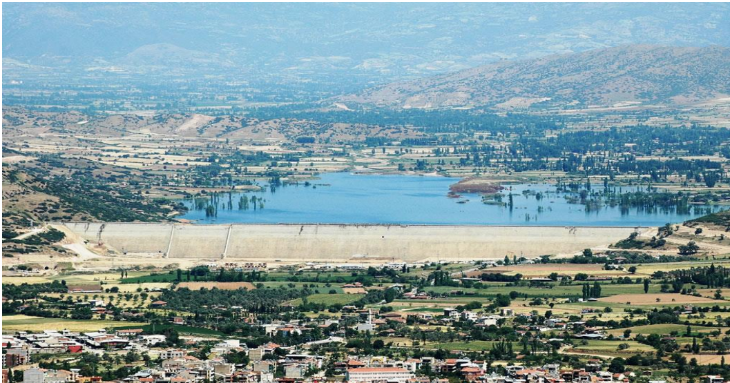
Şekil 8. Beydağ barajı (URL-5).
