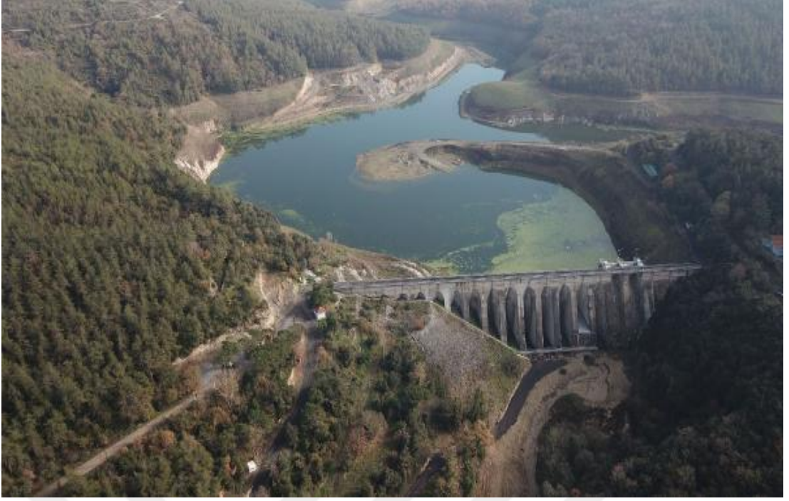
Şekil 3. Payandalı baraj örneği Elmalı Barajı (URL-4).
