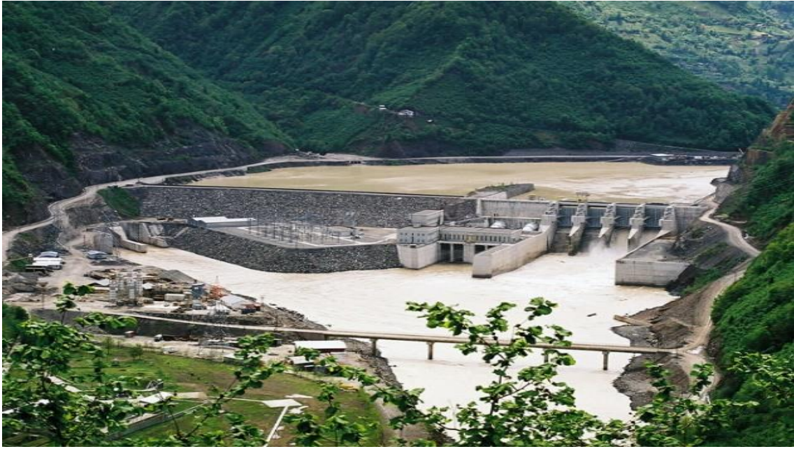
Şekil 13. Muratlı Barajı (URL-5).
