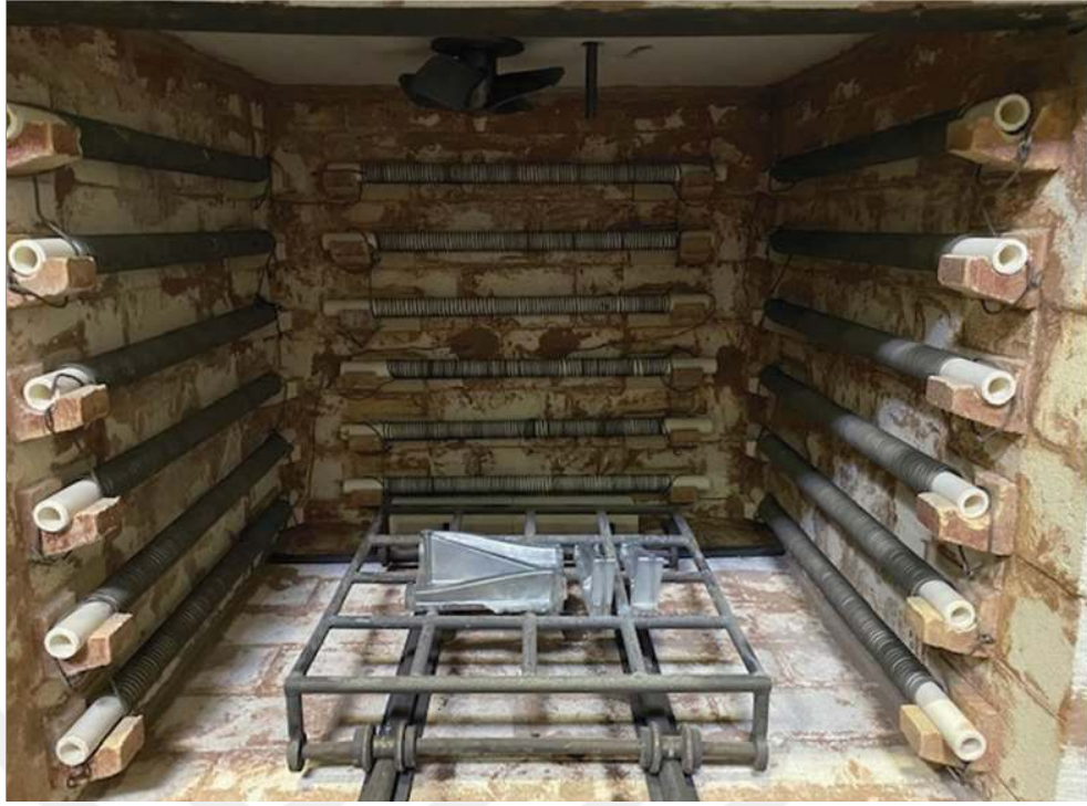
Şekil 3.12 Numunelerin ısıtım fırını içerisindeki yerleşimi
