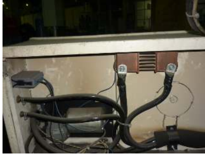
Şekil 5.5 Kaynak makinasına bağlanan şönt
