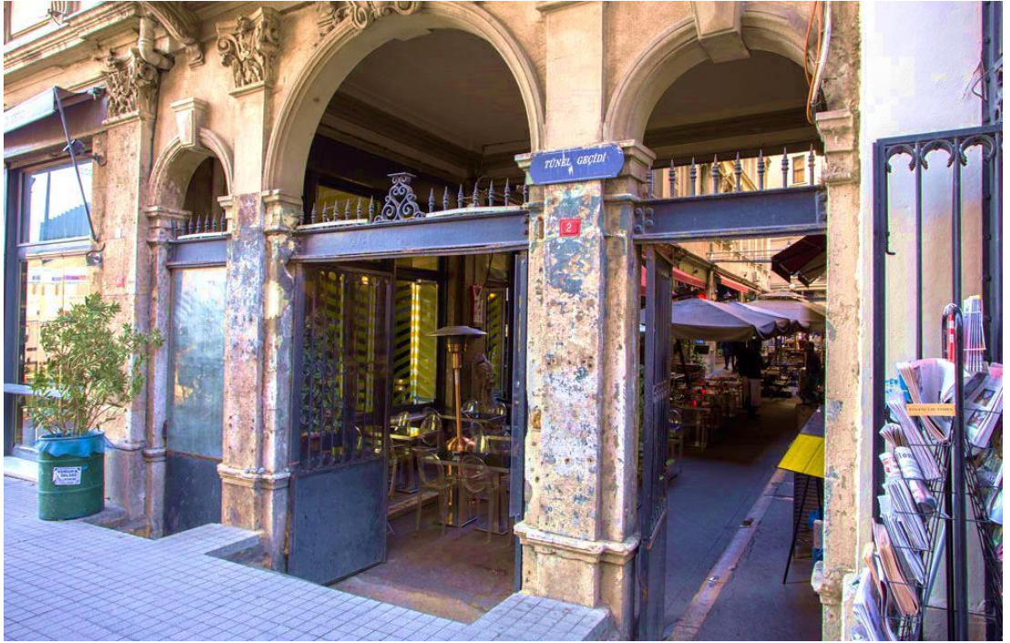
Şekil 4.32 : Tünel Meydanı Sokak Giriş Kemerleri (Url-16)
