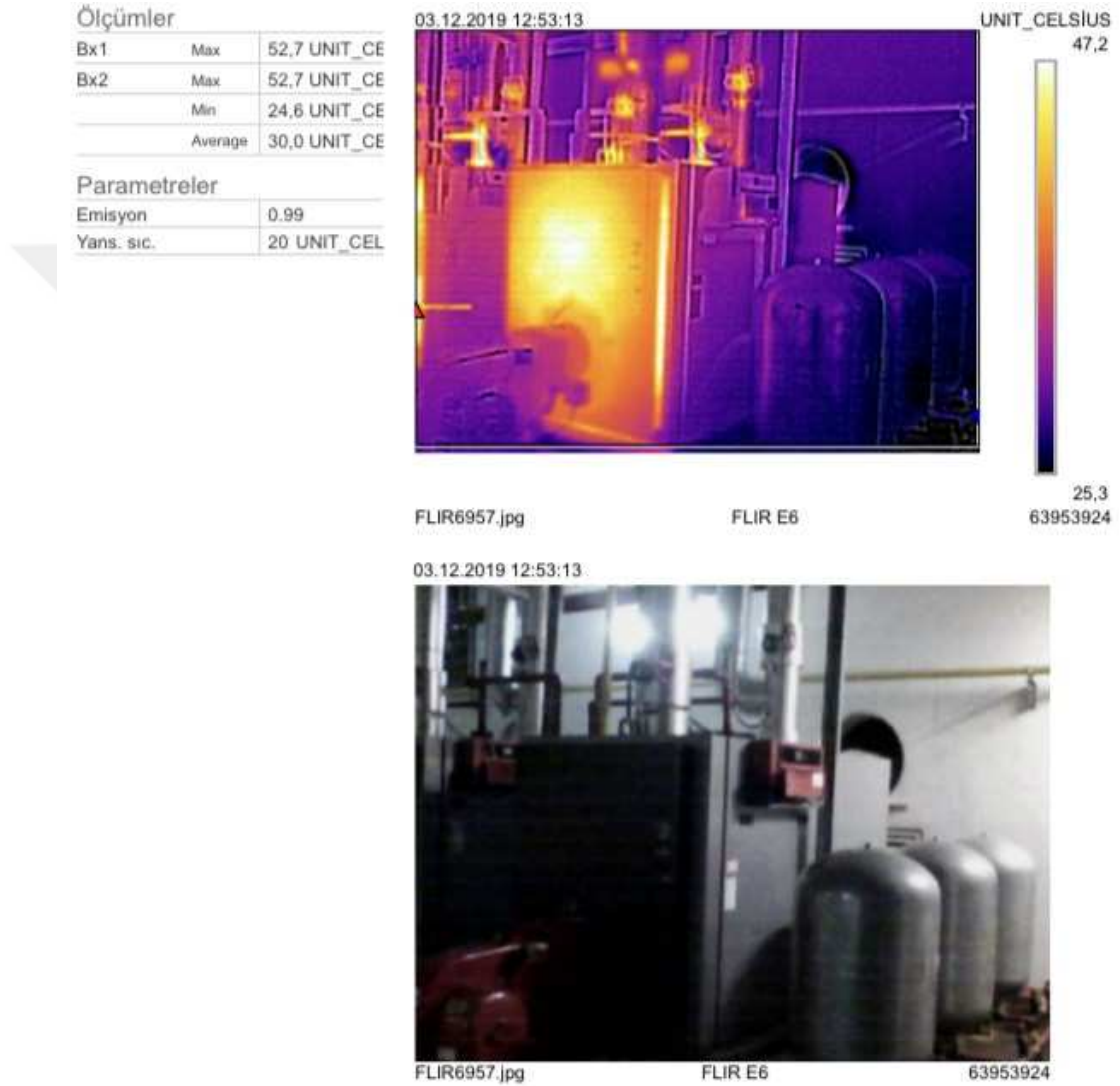
Şekil 4.3. Doğalgaz Kazanları Termal Görüntüleri
