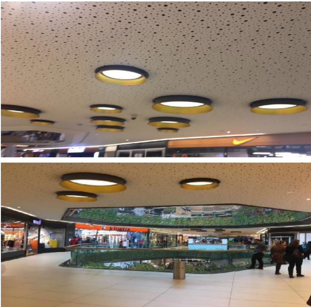
Şekil 23. Zeolit katkılı tam plaka akustik alçıpan (perfore) kompozit malzeme
