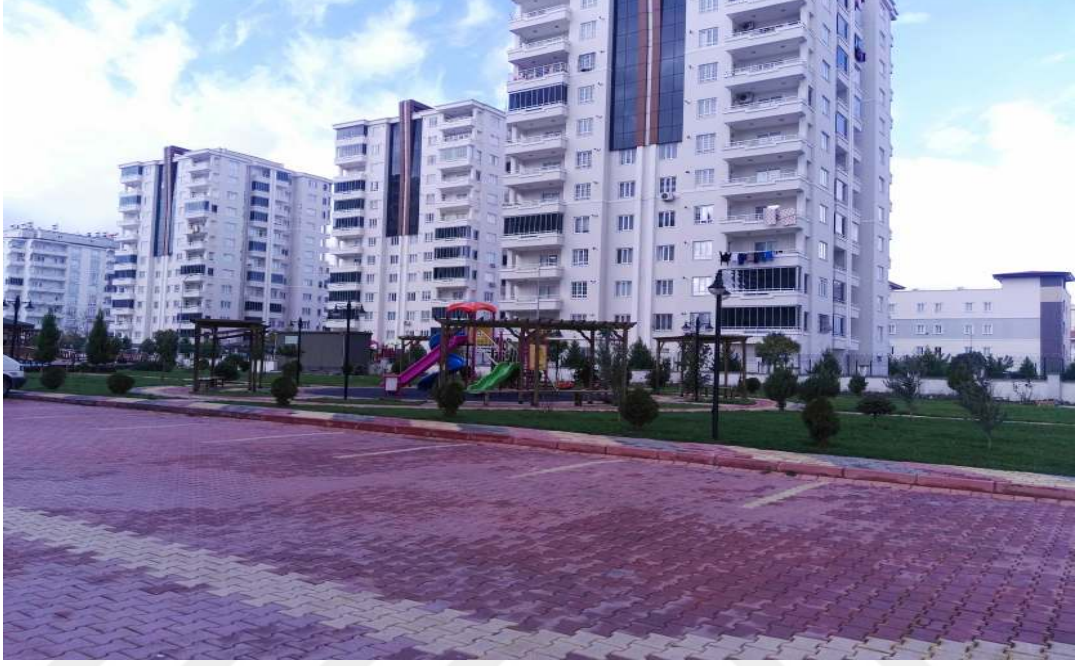
Fotoğraf 1: Güvenlikli Site Mekânı Örneği, Karataş Mahallesi, Gaziantep
