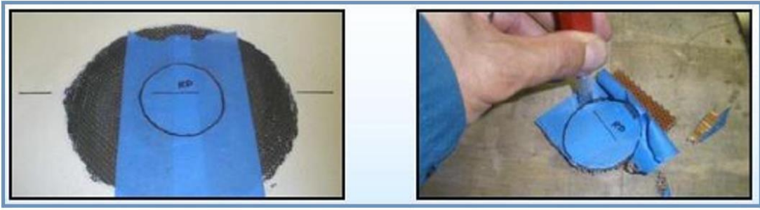
Şekil 6.5. Çekirdek değişimi için taslak hazırlanması (Karaer, 2014)
