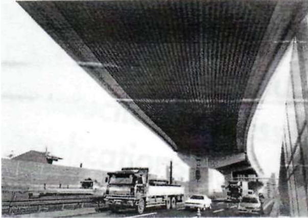
Şekil 3.9 Viyadük altında ses emen levha yapı (Miyoshi vd., 2000).
