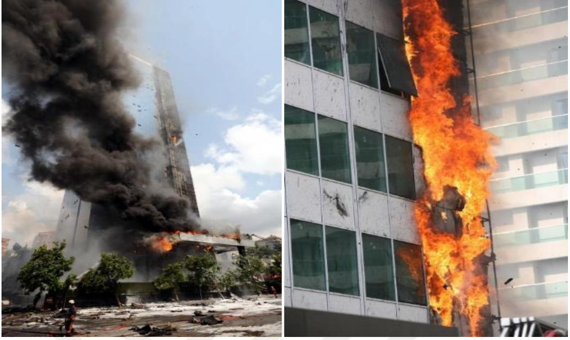
Görsel 2.31. Şişli, Polat Kule'de yangından görünüm [44]
