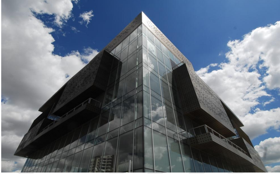
Görsel 2.13. Doğan Medya Merkezi, Ankara , İki taraflı geleneksel alüminyum giydirme cephe sistemi (Alumil, 2011)
