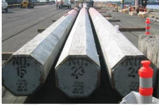
Şekil 3.8. Önceden dökme (prekast) kazıklar [11]
