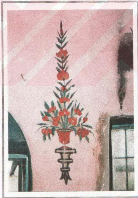
Fotoğraf 136— Giriş kapısı ile pencereler arasında yer alan vazolu çiçek motifi
