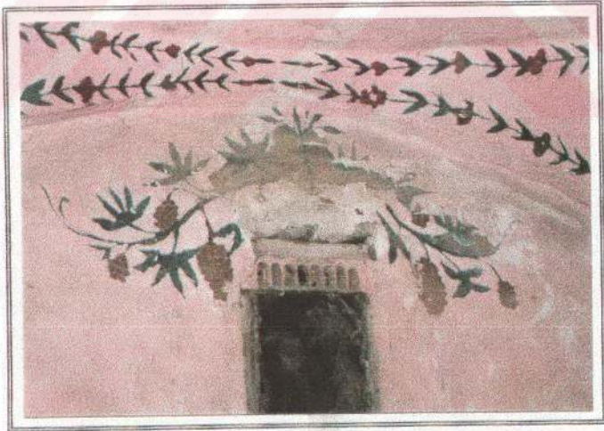
Fotoğraf 129 a-) Mihrap üzerinde bulunan küçük niş içerisindeki bezemeler
