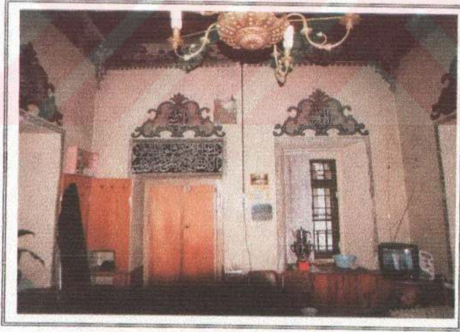
Fotoğraf 62 – Muvakkithanenin giriş kapısının bulunduğu doğu duvarından genel bir görüntü
