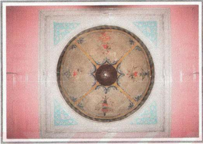
Fotoğraf 194 – Öz Baraklı Camii tavanındaki kubbesinin genel görüntüsü
