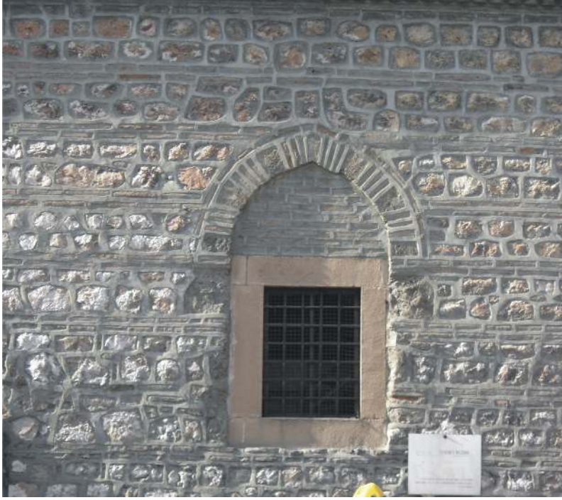
Resim 4.2. Pencereilerin alt kotundan yukarı kısımlarda duvar örgüsü (2007)
