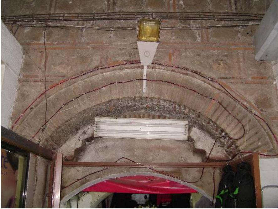
Resim 9.24. Doğu giriş kapısı kemerler
