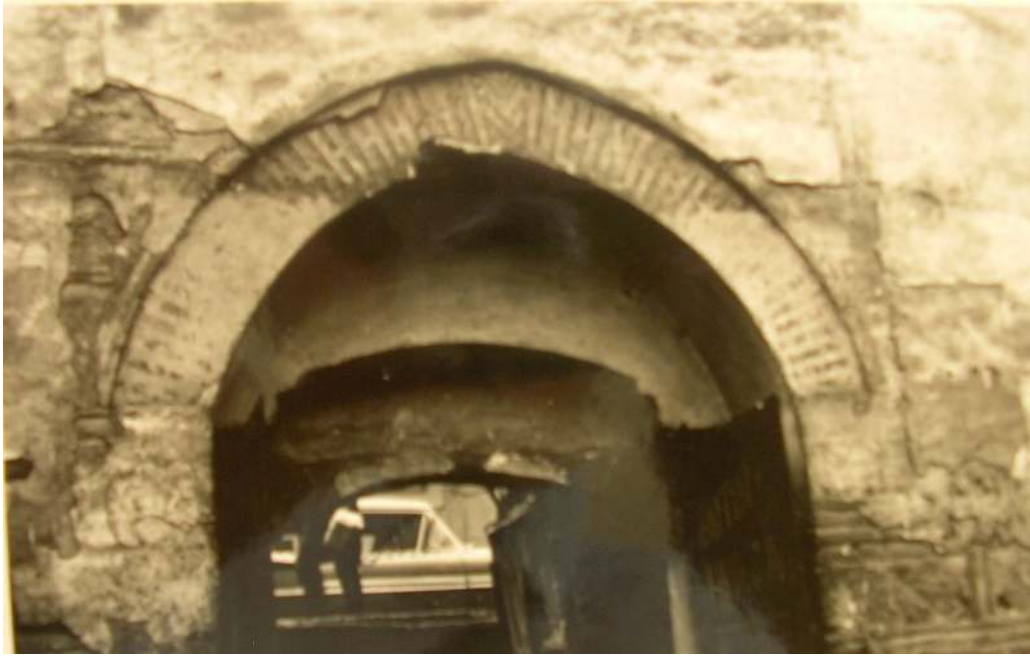
Resim 2.18. 1974 VGM onarımı öncesi bedesten içi güney girişi (VGM arşivinden)
