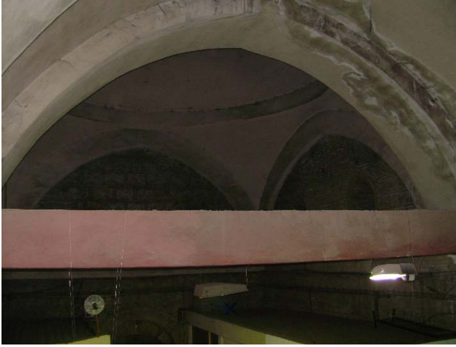
Resim 4.12. Kemerler arasındaki betonarme gergi (2007)
