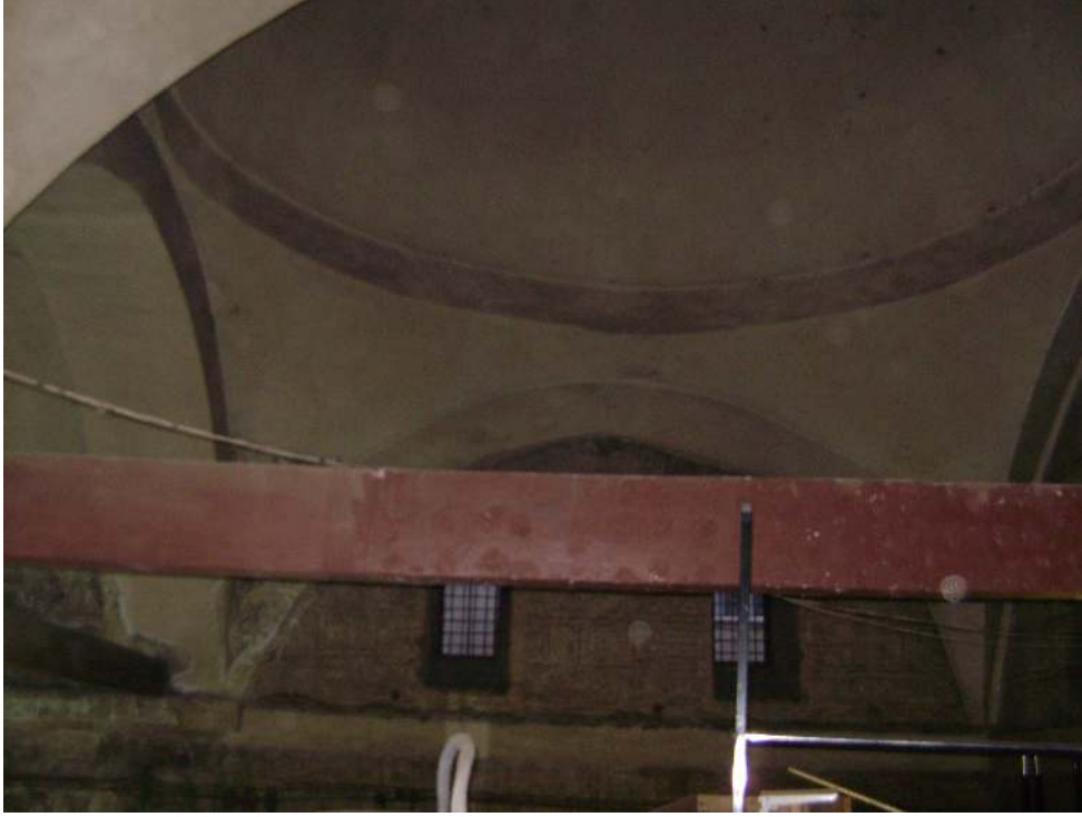
Resim 4.10. Kubbeleri taşıyan bedesten içindeki kemerler (2007)
