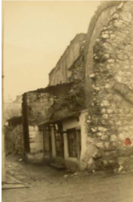
Resim 6.6. 1974 VGM onarımı öncesi kuzey cephe (VGM arşivinden)
