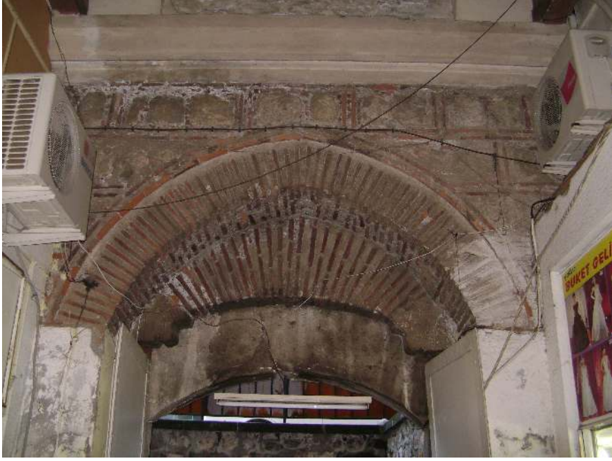
Resim 9.23. Güney giriş kapısı kemerler
