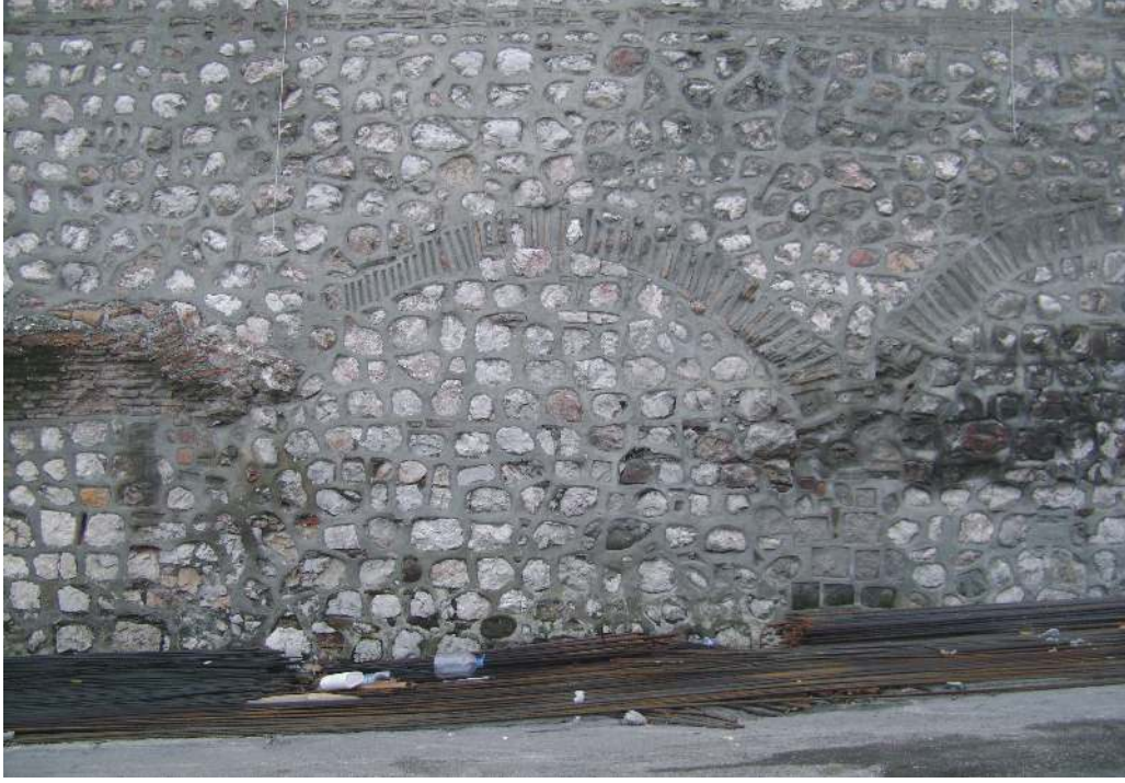
Resim 6.3 Batı cephesindeki tonoz izleri (2007)
