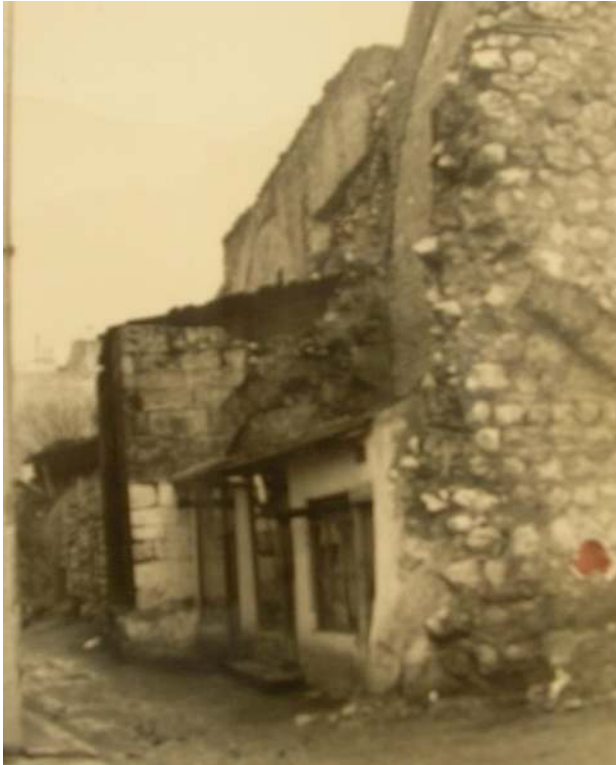
Resim 4.8. 1974 VGM onarımı öncesi kuzey cephe (VGM arşivinden)
