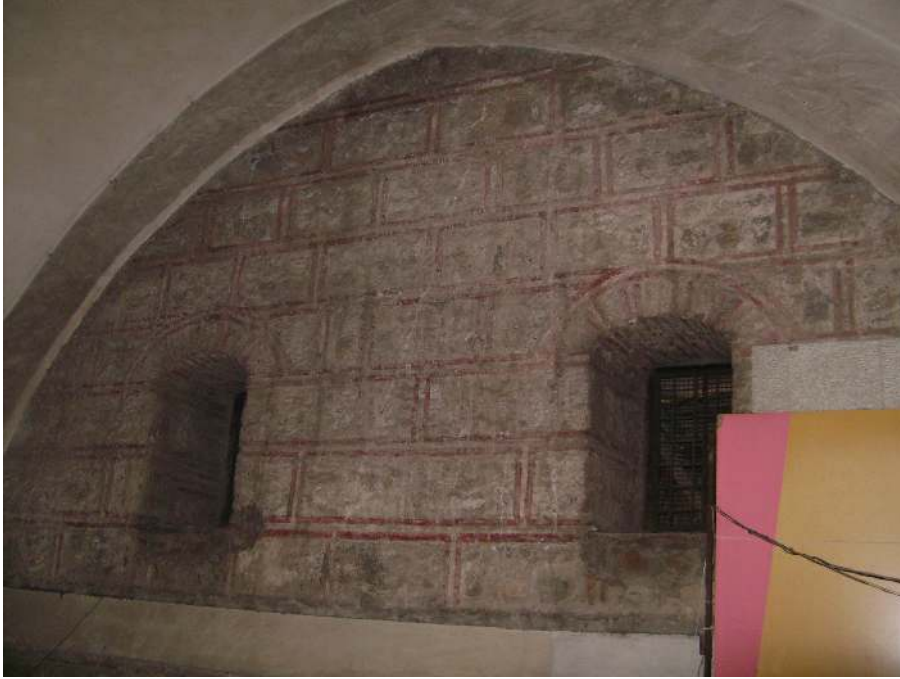
Resim 9.36. Doğu cephesi pencereler
