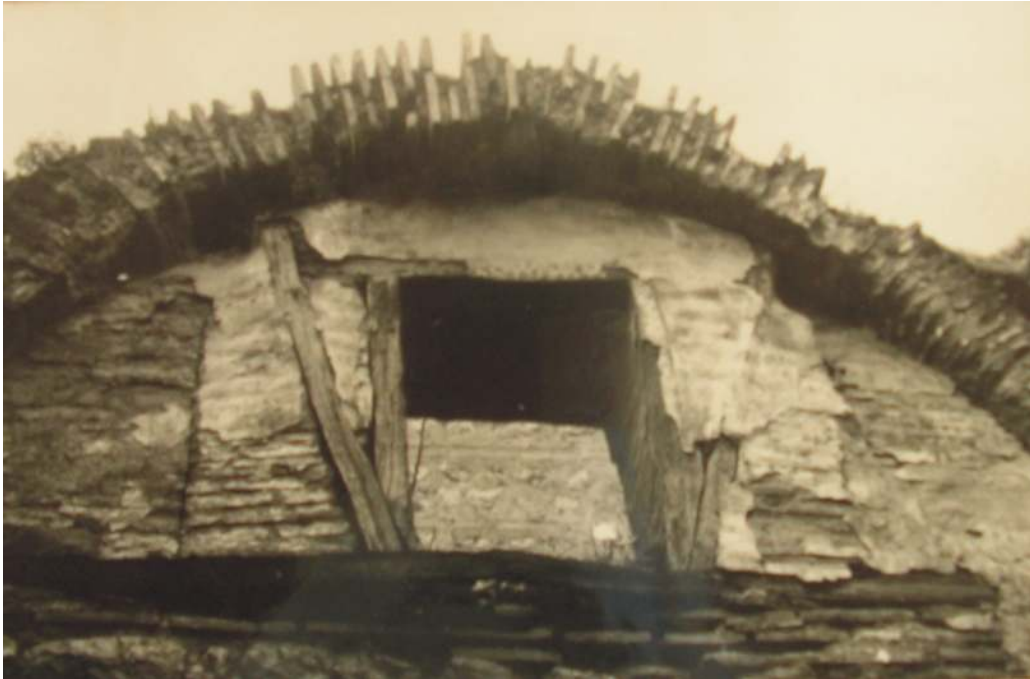
Resim 2.20. 1974 VGM onarımı öncesi bedesten içinden (VGM arşivinden)
