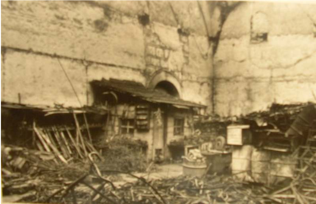
Resim 2.16. 1974 VGM onarımı öncesi bedesten içi (VGM arşivinden)
