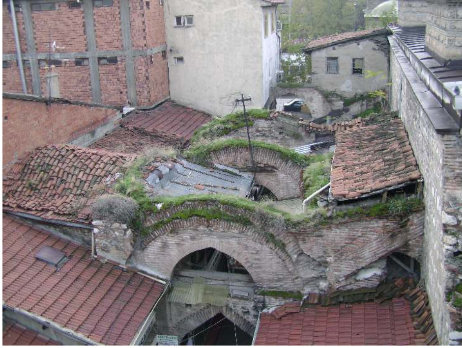
Resim 3.4. Arasta kısmı üst örtüsünde bitkilenme meydana gelmiştir (2007)
