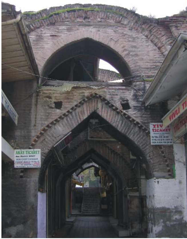
Resim 2.9. Arasta kemerleri sivri kemer türündedir (2007)
