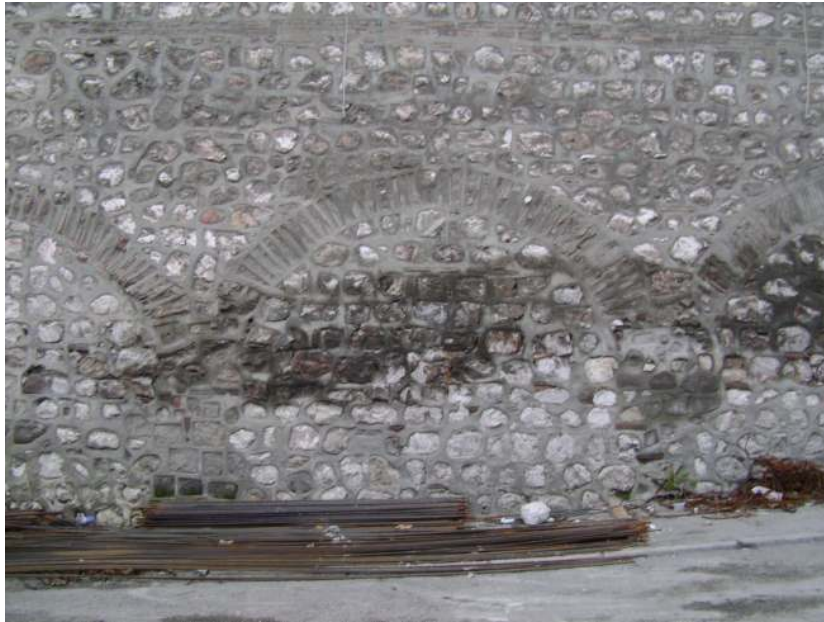
Resim 4.1. Pencerelerin alt kotundan aşağı kısımlarda moloz taş (2007)
