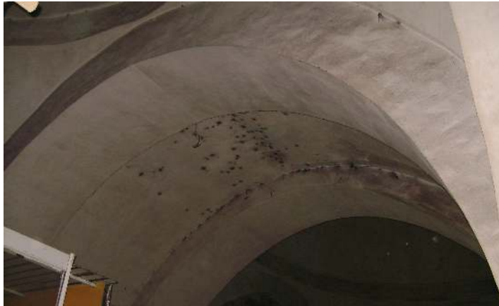
Resim 4.17. Ortadaki paye ile beden duvarlarına oturan kemerler (2007)
