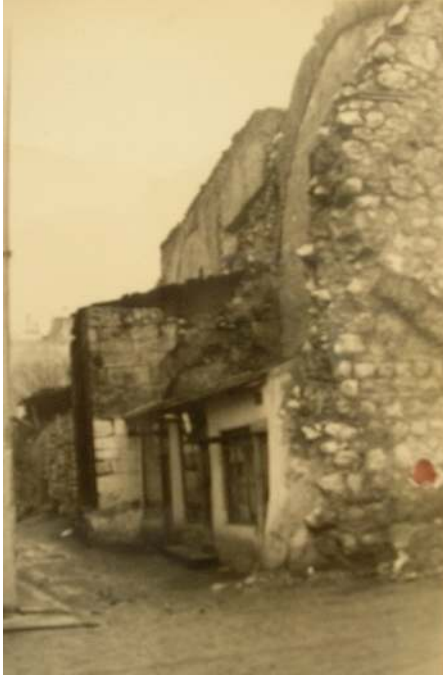
Resim 2.23. 1974 VGM onarımı öncesi kuzey cephe (VGM arşivinden)
