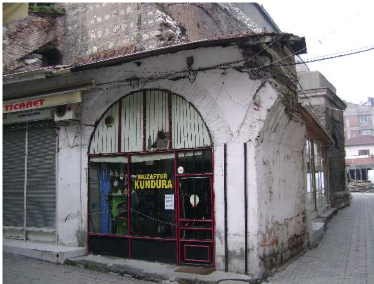
Resim 2.8. Bedesten, yapı genelinde basık kemerlere sahiptir (2007)
