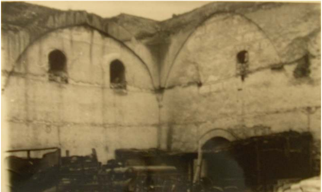
Resim 2.14. 1974 VGM onarımı öncesi bedesten içi (VGM arşivinden)
