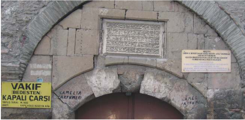
Resim 4.5 Kapı kemer ve alınlıklarında kullanılan kesme taş (2007)
