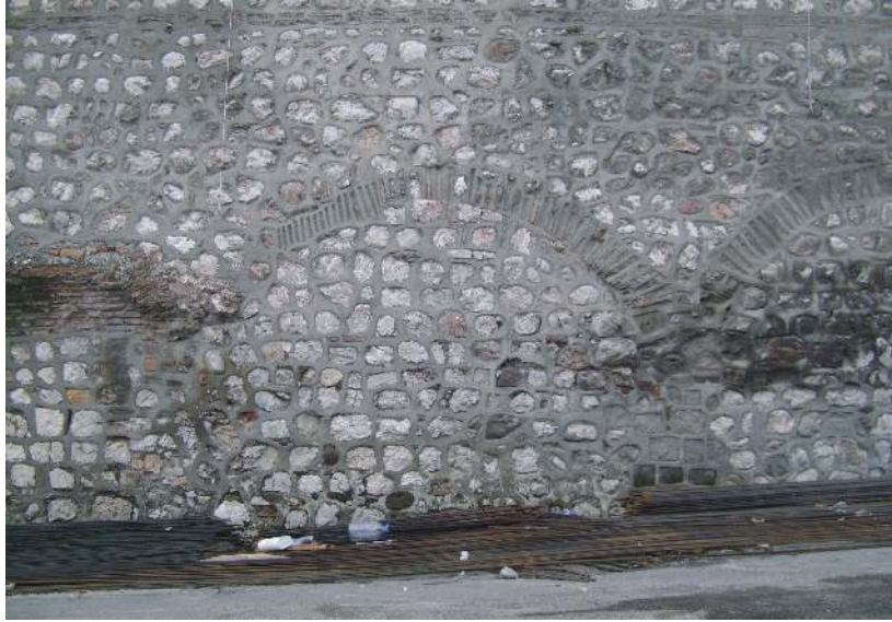
Resim 3.2. Batı cephesindeki kemer izleri (2007)
