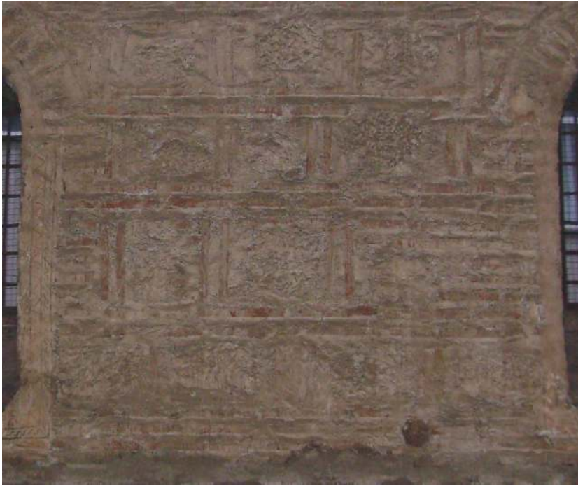
Resim 4.3. Bedesten içerisinde kullanılan duvar örgüsü (yatay ve düşey iki sıra tuğla araları kaba yonu taş) (2007)
