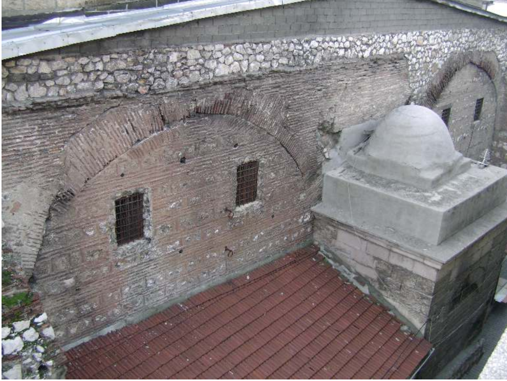
Resim 3.3. Kuzey cephesinde sonradan yapılan kubbe ve duvarlar (2007)
