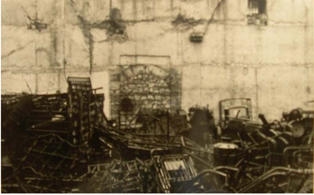
Resim 2.15. 1974 VGM onarımı öncesi bedesten içi (VGM arşivinden)
