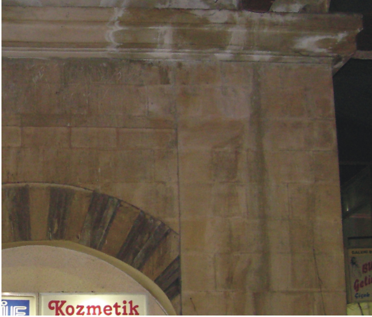
Resim 4.7. Bedesten içindeki payelerde kullanılan kesme taş (2007)
