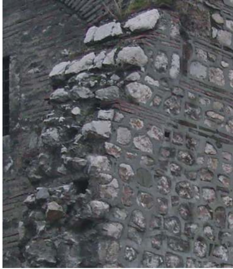
Resim 4.14. Duvar örgüsü (dış)(2007)
