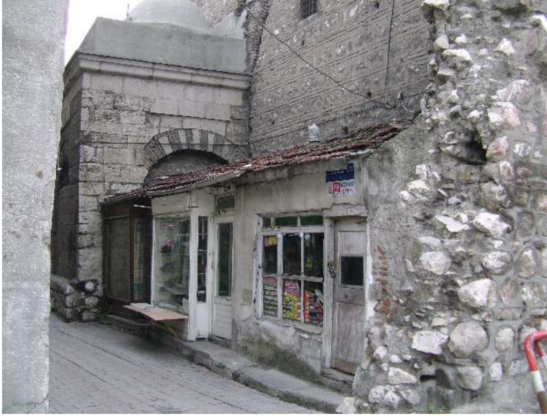
Resim 9.4. Kuzey cephesi dükkanlar
