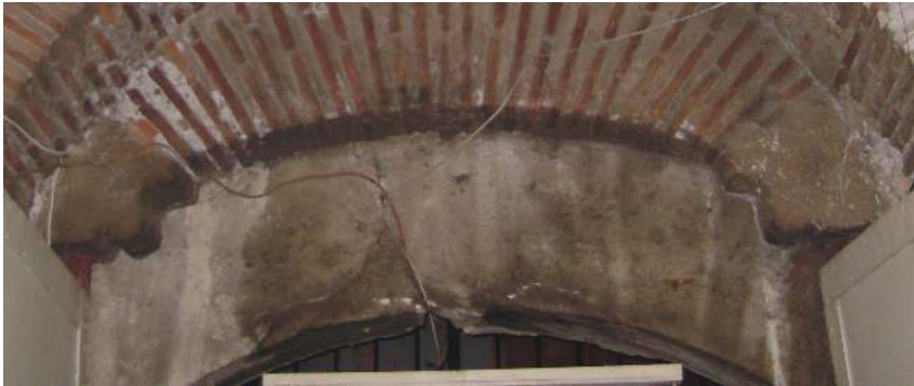
Resim 4.6. Kapı tuğla kemerleri bitiş noktalarındaki kesme taş (2007)
