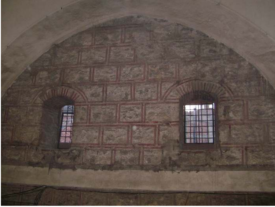
Resim 9.31. Batı cephesi pencereler
