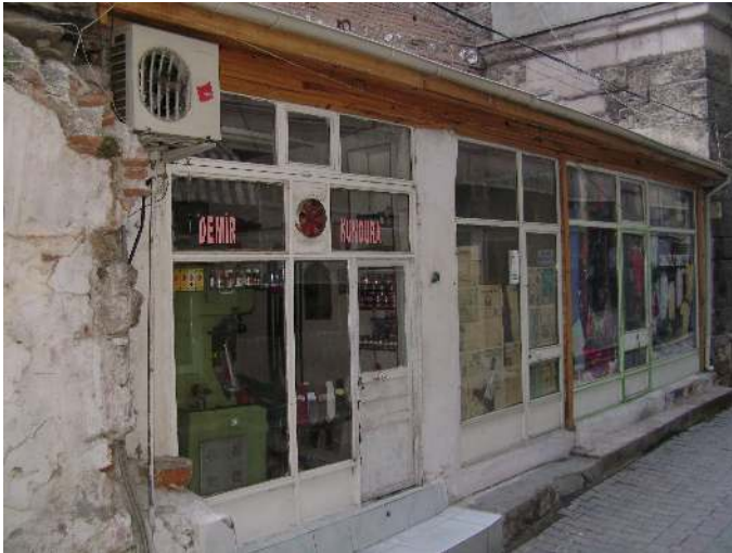
Resim 9.6. Kuzey cephesi dükkanlar
