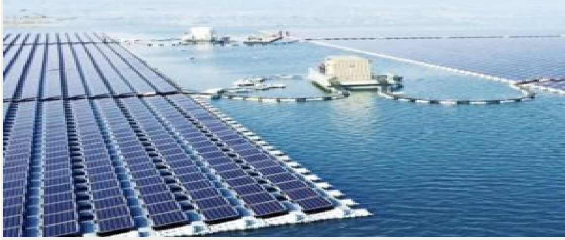
Şekil 2.8. Yüzen güneş enerjisi santrali örneği (Dünyaenerji, 2021)
