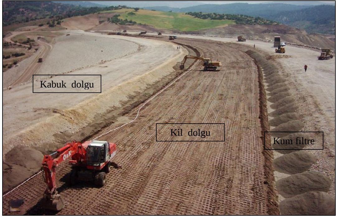
Şekil 2.1. Kil dolgu serim ve sıkıştırması –Ayvalı Barajı
