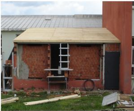
Şekil 3.3. Güney duvarın yapılışı
