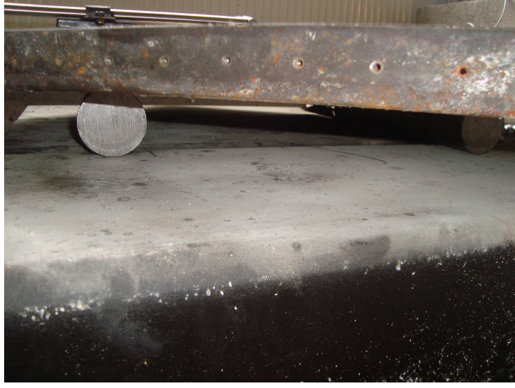
Şekil 3.12. Sistem tabanına yerleştirilen mesnetlerin görünümü
