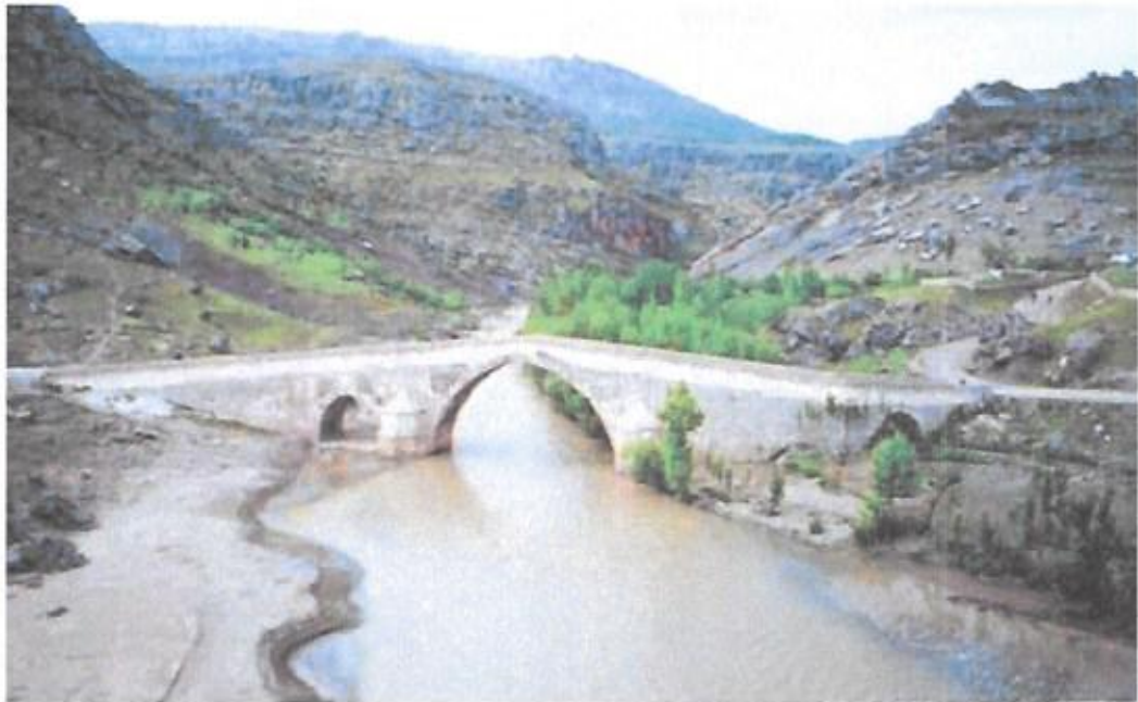
Şekil 3.9: Çermik'te Haburman köprüsü ve yan gözünden geçen değirmen kanalı (Arisoy, 2008). (Artuklu Dönemi, M.S. 10. – 13. yüzyıl)
