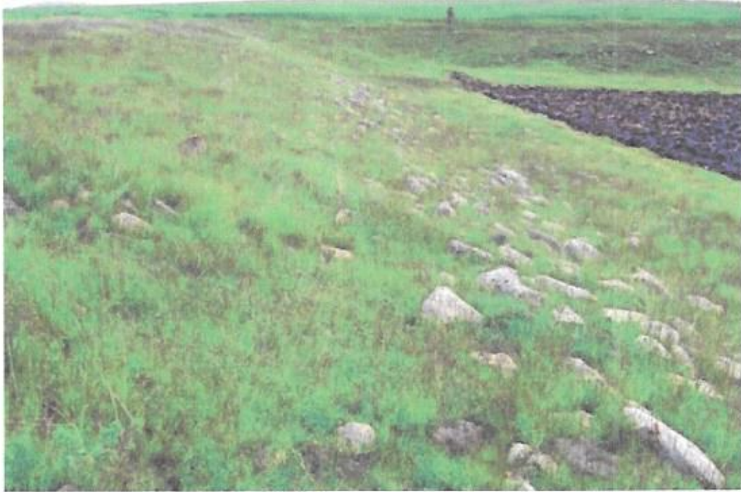
Şekil 4.11: Karakuyu barajı gövde mansabı (URL -3).
