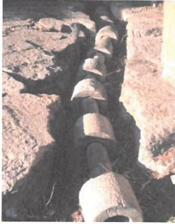
Şekil 3.43: Bergama’da bulunan taş maşonlu kurşun boru (Baykan, 2008).
