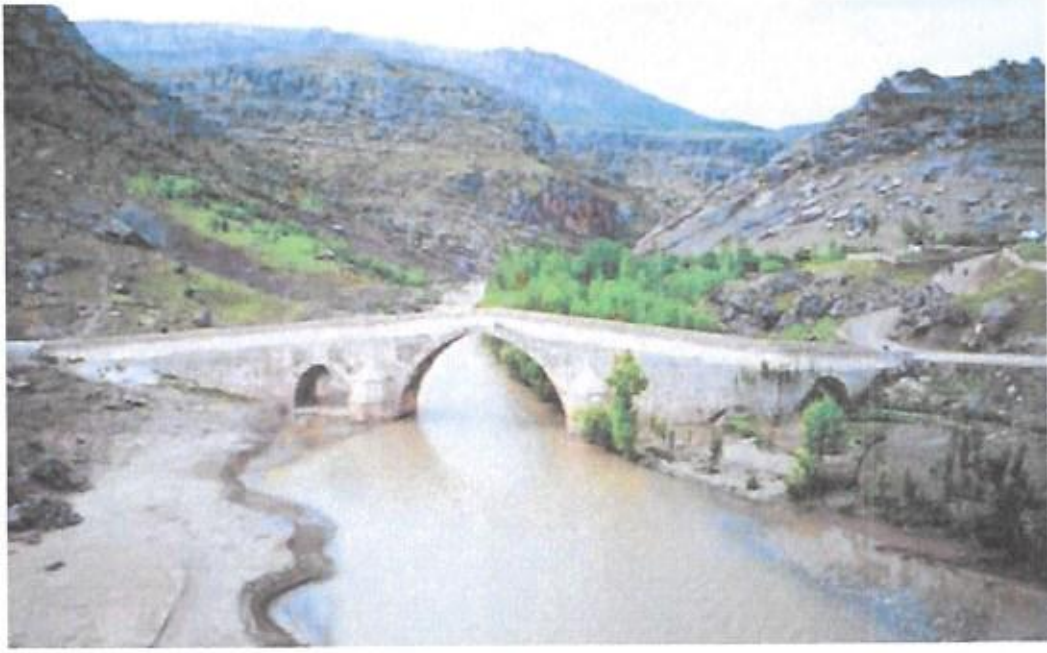
Şekil 3.66: Haburman köprüsü ve yan gözünden geçen değirmen kanalı (Arisoy, 2008).
