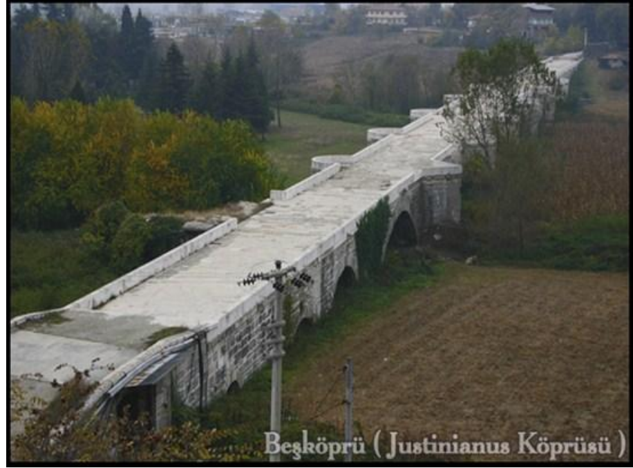
EK 100- SAKARYA/SANGARIOS/I.JUSTİNİANOS KÖPRÜSÜ
