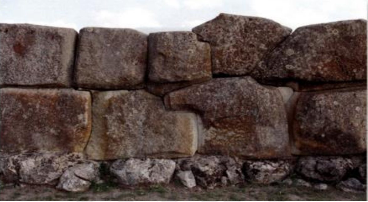
Şekil 70. Alacahöyük duvar örneği.
