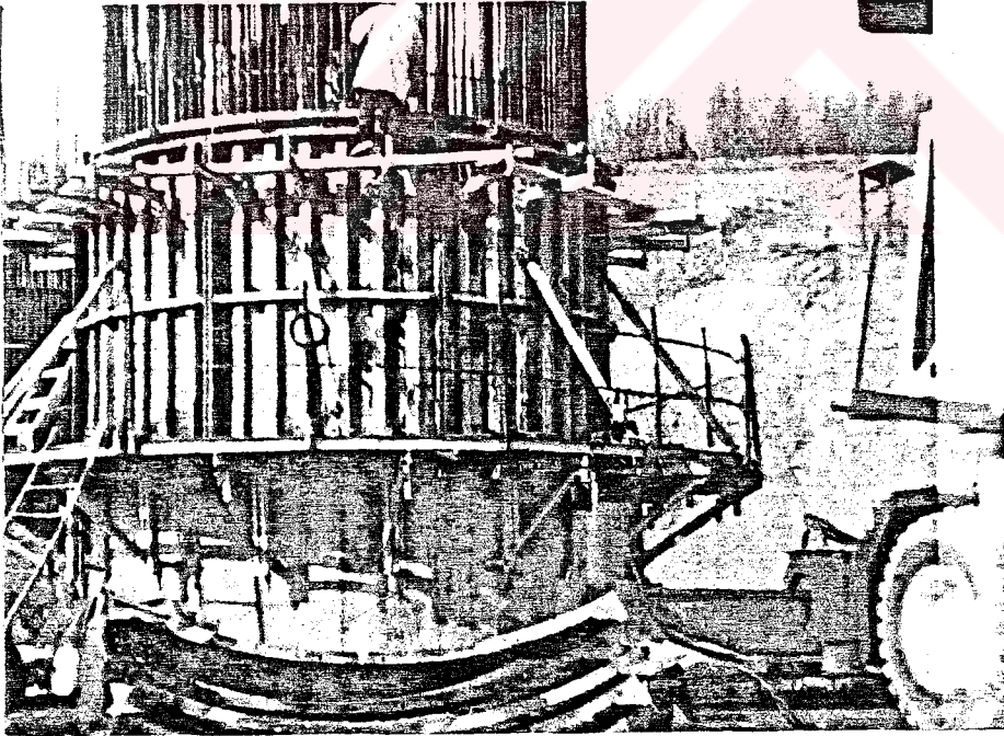
RESİM EK-6 VİYADÜK AYAKLARININ KALIP ÇALIŞMALARI
