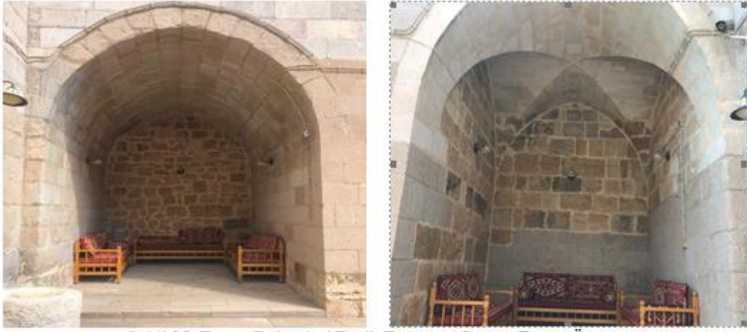
Şekil 49. Eyvan Bölümleri Beşik Tonoz ve Çapraz Tonoz Örtüsü,2025
