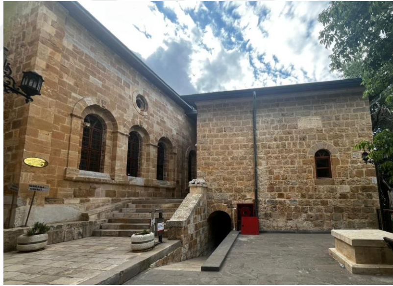
Şekil 56. Paşa Çardağı Güney Cephesi, 2025
