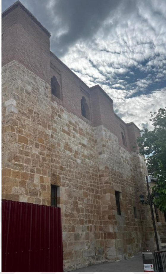
Şekil 38. Eshab-ı Kehf Külliyesi Kuzey-Batı Cephesi (Batıdan Kuzeye Bakış), 2025
