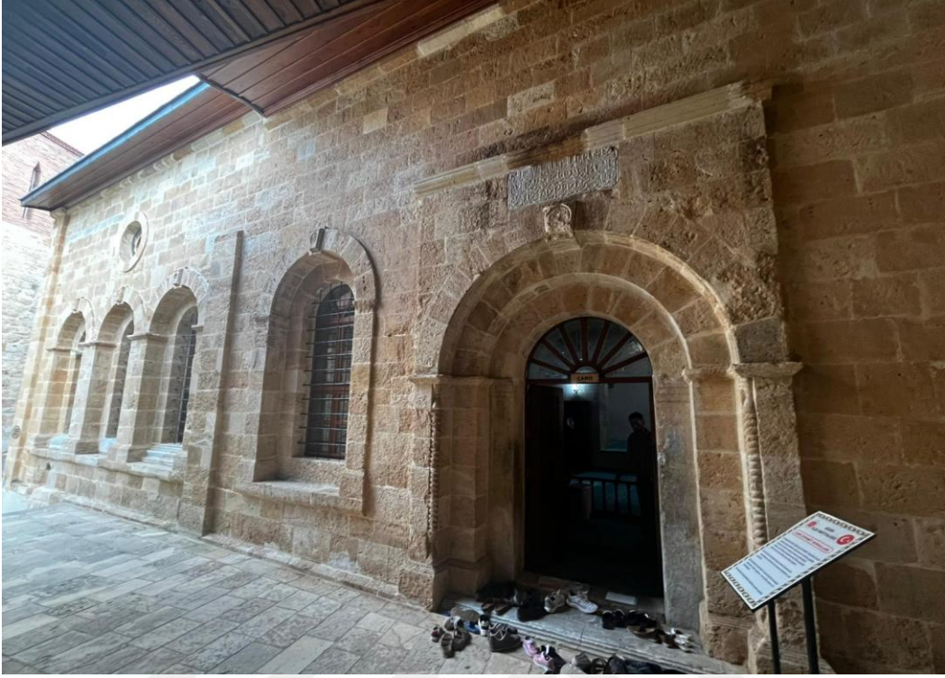
Şekil 27. Eshab-ı Kehf Kllyesi Cami Doęu Cephesi,2025
