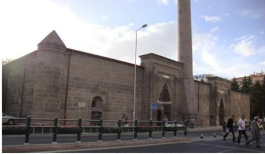
Şekil 3. Kayseri Hacı Kılıç Cami ve Medrese Doğu Cephesi (Şaman, 2012)
