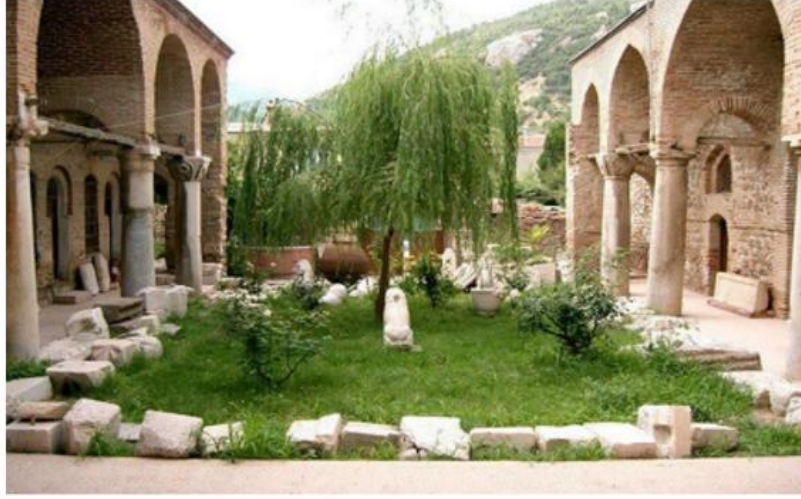
Şekil 11: Taş Medresenin iç avlusunun taş kapıya doğru görünüşü (Restitüsyon Rapor, 2009)
