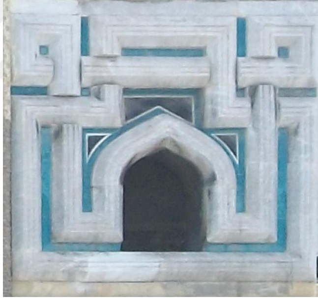
Resim 48: Konya Sahip Ata Camii Taçkapı Sağ Pencere, Düğüm Kompozisyonu.
