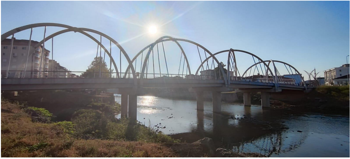
Şekil 4. 3: Terme Çayı Üzerine Yapılan Modern Yaya ve Araç Köprüsü.
