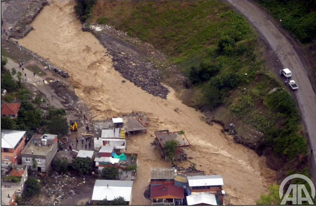
Şekil 3.1: Sel Afetinde Yıkılan Evler.
