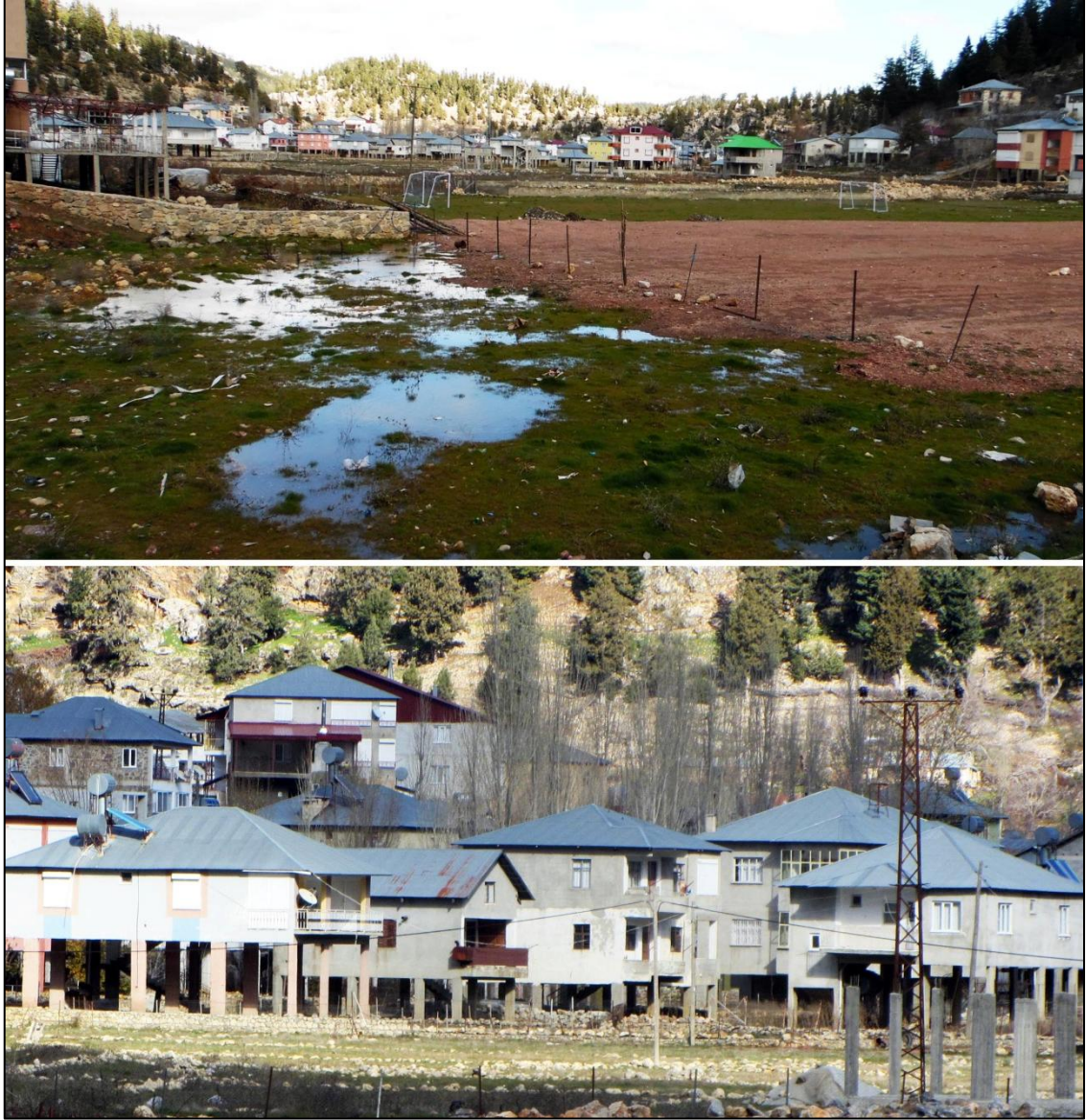
Foto 115. Abanoz yaylası ve polyesi. Özellikle kış aylarında tabandaki su seviyesi yükselen ova tabanı (üstte) ve bu duruma göre beton sütunlar üzerine inşa edilen yayla evleri (altta)
