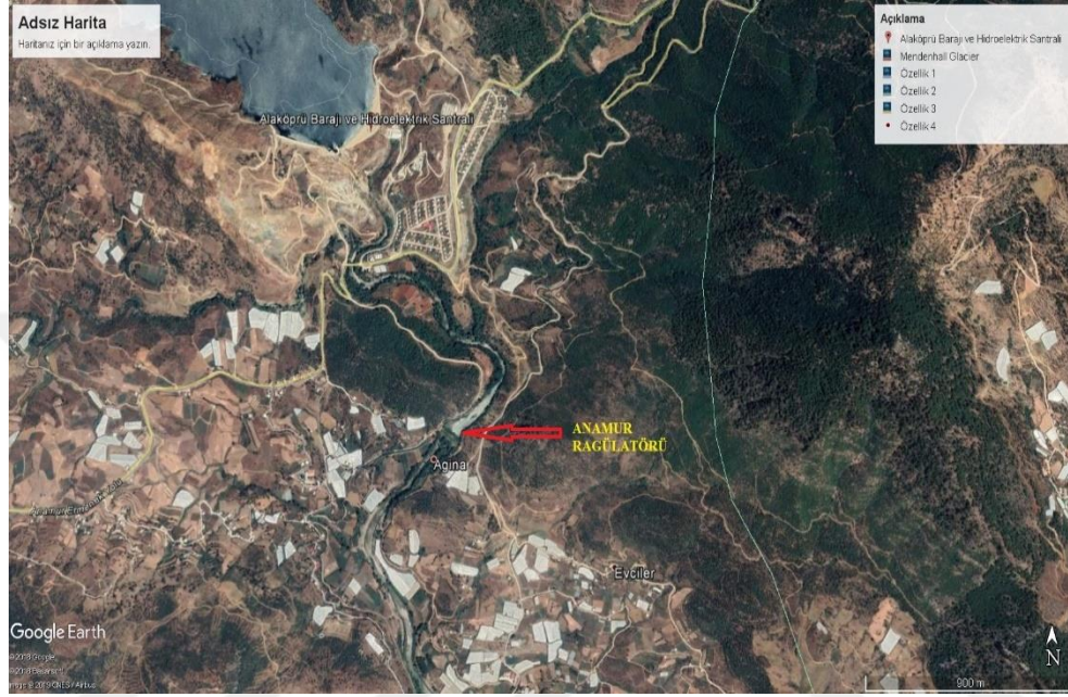
Şekil 3.2. Alaköprü Barajı ve Anamur Regülatörü
