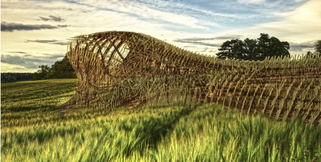
Şekil 5.96 : Örtünün bahar uyarlaması; örgü; saman, taşıyıcı sistem; ahşap.
