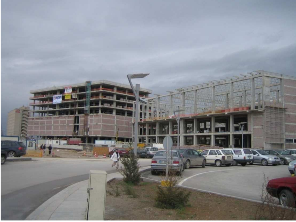
Resim 12.1. Cephe inşaat görüşü
