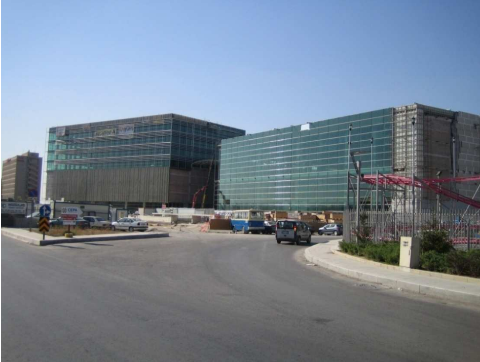
Resim 12.2. Cephe inşaat görüşü
