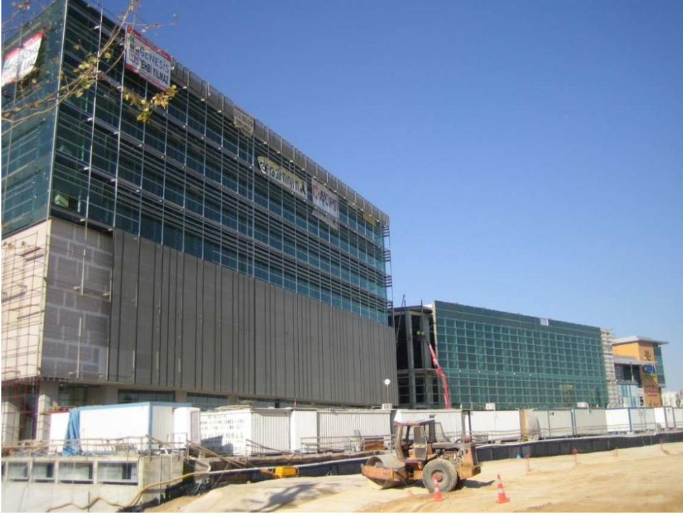
Resim 12.3. Cephe inşaat görüşü
