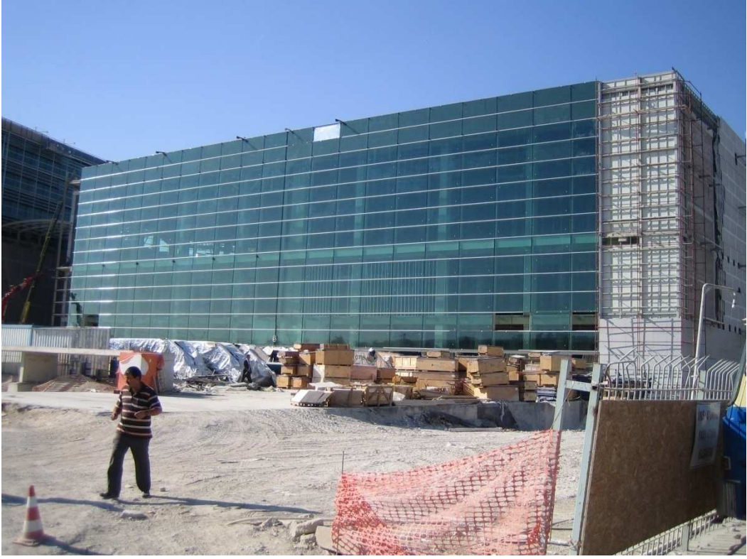
Resim 12.5. Cephe inşaat görüşü
