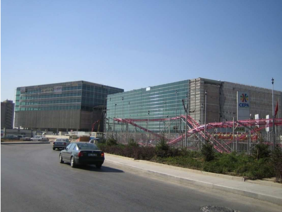
Resim 12.4. Cephe inşaat görüşü
