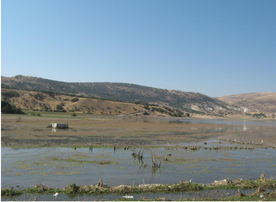
Resim 3.3. Asartepe Baraj Gölü sağ sahil görünümü
