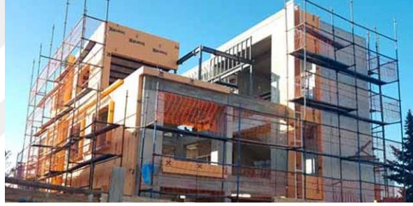
Şekil 4.32. İnşaat aşaması (Özgüven, 2018)
