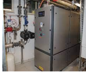
Şekil 4.67.Kojenerasyon ünitesi
