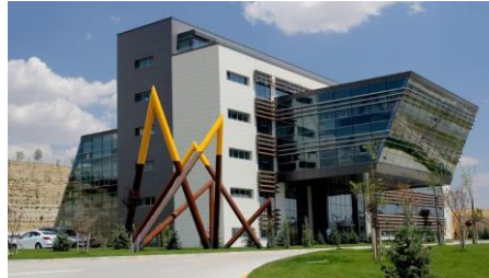
Şekil 4.4. Prokon-Ekon Şirketler Grubu Binası (Prokon,2024)
