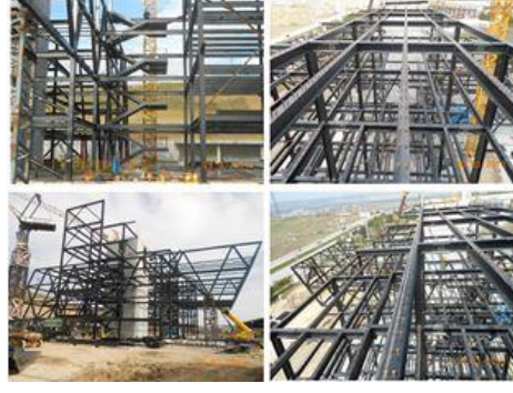
Şekil 4.21. İnşaat esnasında çelik imalatı (Prokon,2014)
