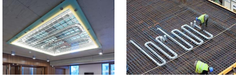
Şekil 4.46. Soğuk kiriş ve şantiyede uygulaması (TMB,2012)
