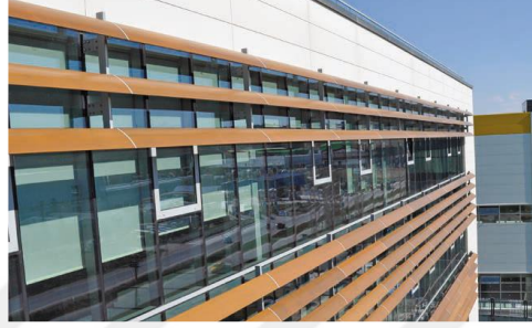
Şekil 4.18. Bina cephesi ve güneş kırıcılar (Prokon,2014)
