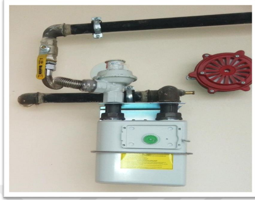
Şekil 4.46. Mekanik sayaca müdahale edilmiş,
