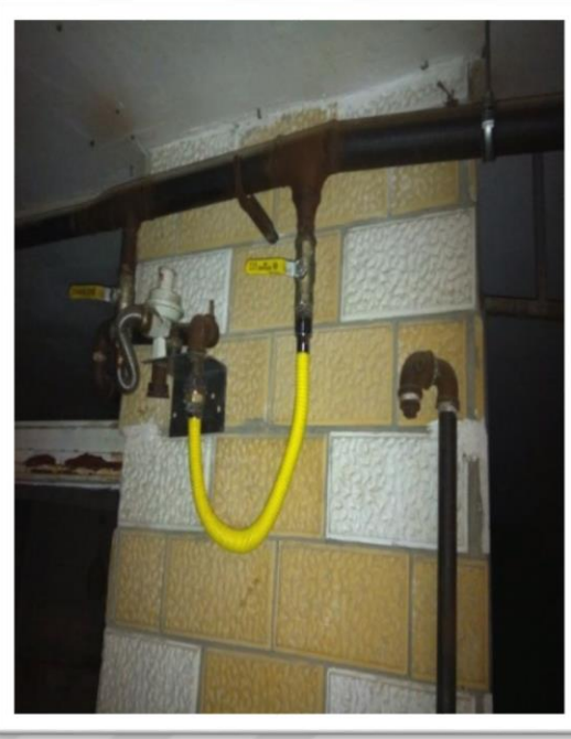
Şekil 4.44. (a-d) Doğalgaz sayacı olmadan gaz kullanımı,
