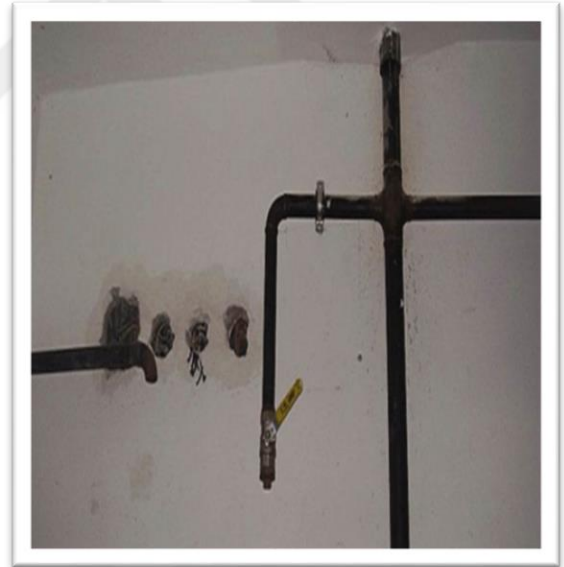
Şekil 4.37. (a,b) Hatalı iç tesisat imalatları,
