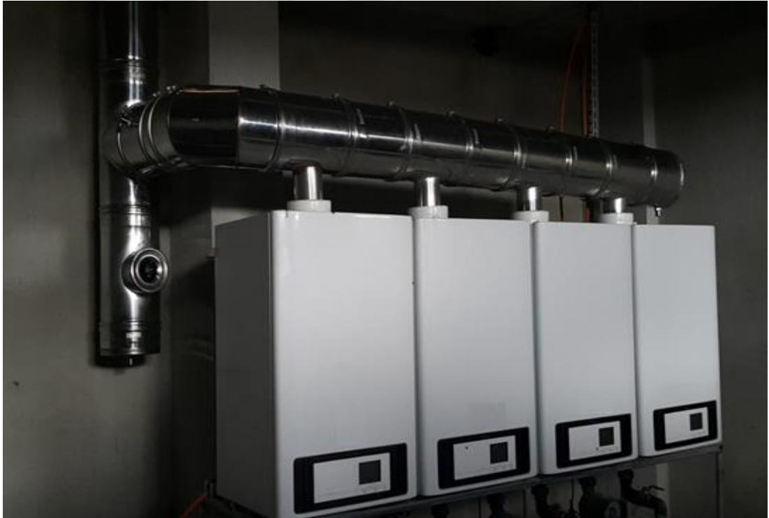
Şekil 4.48. Birleşik (Kaskad) baca sistemi
