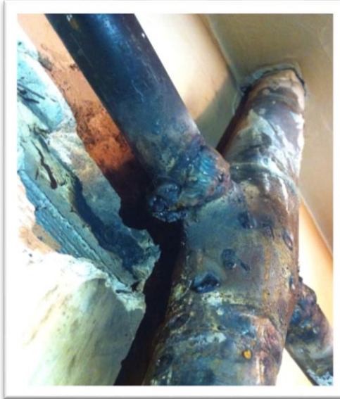
Şekil 4.37. (a,b) Hatalı iç tesisat imalatları,
